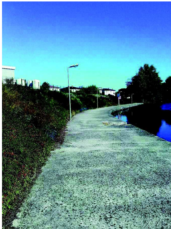
Figure 10 : Photographies de la digue
