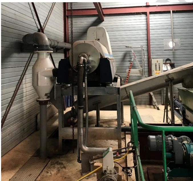
Figure 3 : Photographie du système de déshydratations des boues (Source : Eau Mega)
