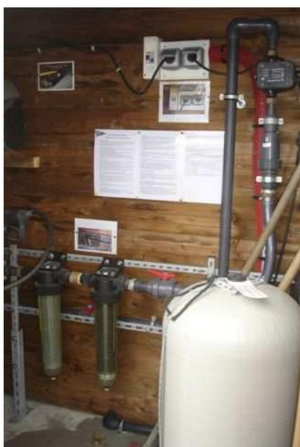
*Dispositif de filtration et de mise en surpression du circuit de lavage.
