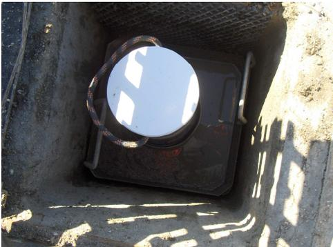
Pendant l'opération de carénage le tube obturateur « voyant blanc » doit être en place verticalement dans chaque regard afin que les effluents soient acheminés vers le bac de décantation.
