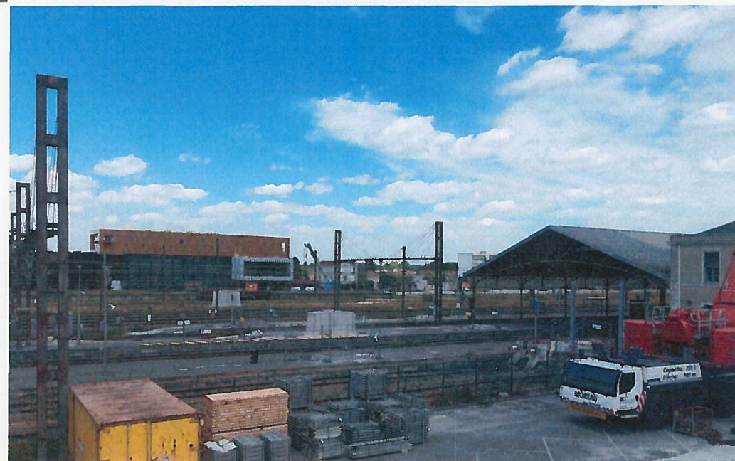
2-Vue EST depuis la Gare
