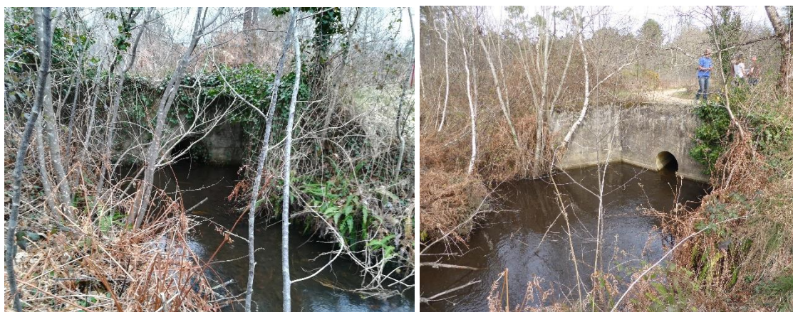
Fig. 26. Ouvrage à aménager, vu amont (côté travaux) et vu aval
