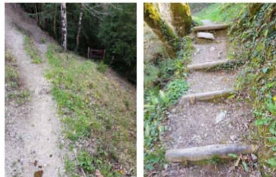
**Fig. 6. Exemple d'aménagement « bois » proposé (à gauche état existant, à droite, exemple d'ouvrage réalisé sur un autre site) (Merlin, 2019).**
