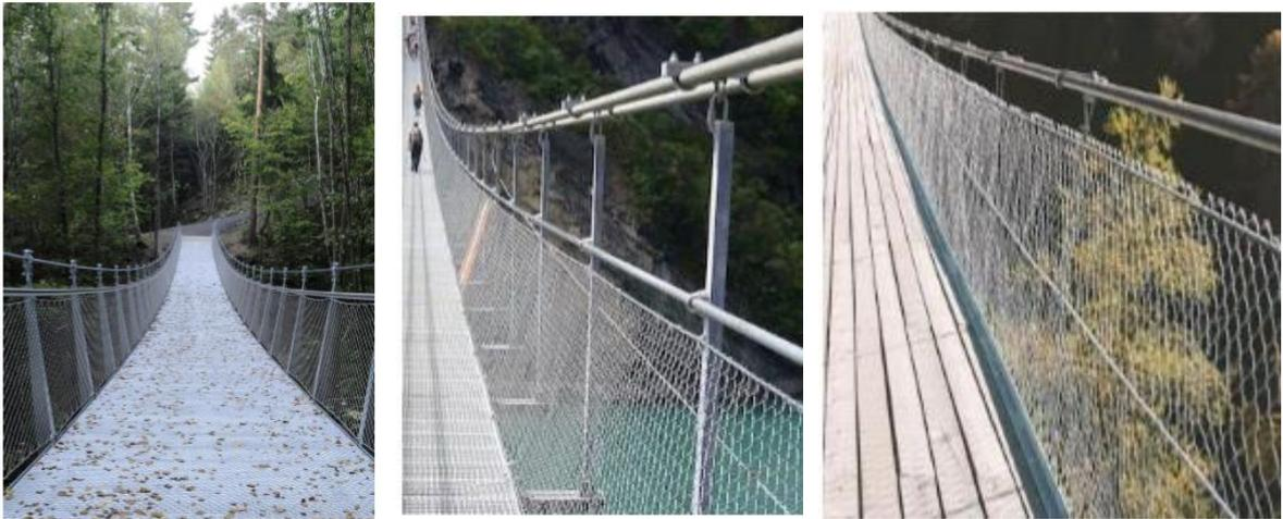
**Fig. 18. Illustrations des garde corps les plus sécuritaires proposés (présence de filet de protection) (Merlin, 2019)**
