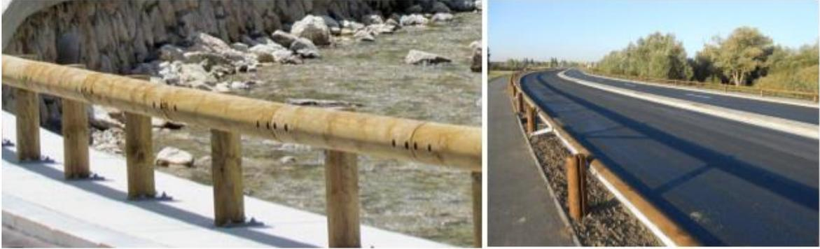
**Fig. 25. Exemple de protection acier et habillage bois (Merlin, 2019)**
