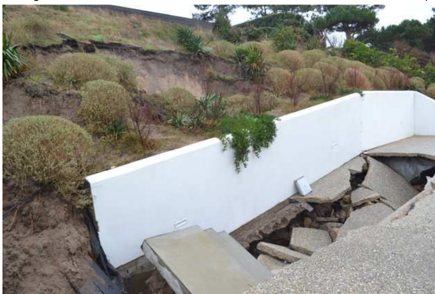
Figure 8 : exemple d'affouillement du terrain dunaire suite à la ruine d'un perré consécutive à une tempête
