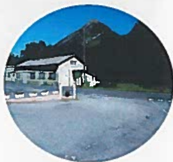
Démolition du bâtiment « Boutiques d'Ossau » Montant estimé : 64 500 €HT, variable suivant diagnostics
