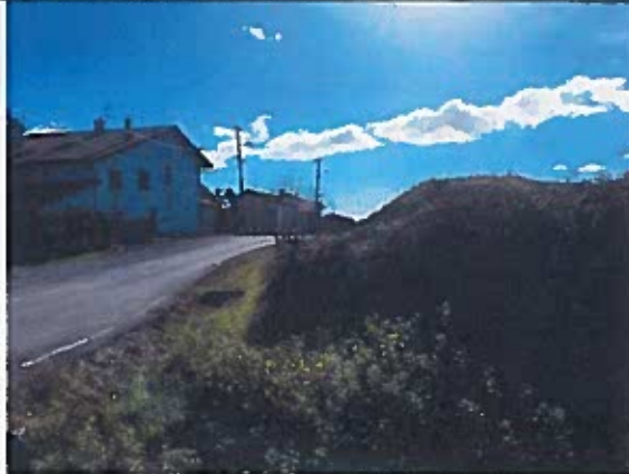
3 – Photo prise depuis la route de Lavigne (ARTELIA, 2019)
