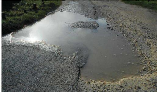
Présence de nids de poule à la fois sur la voie de circulation en enrobé et sur les zones de stationnement en calcaire.
