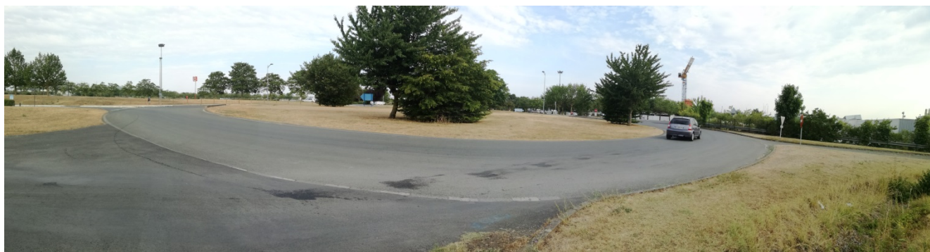
PHOTO 1 : Rond-point en limite Est d'opération (Juillet 2019)
