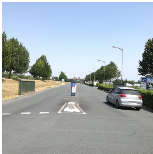
PHOTO 4 : Avenue du Futuroscope longeant la limite Est du projet (Juillet 2019)
