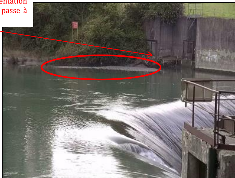
Vue depuis la rive droite du barrage
