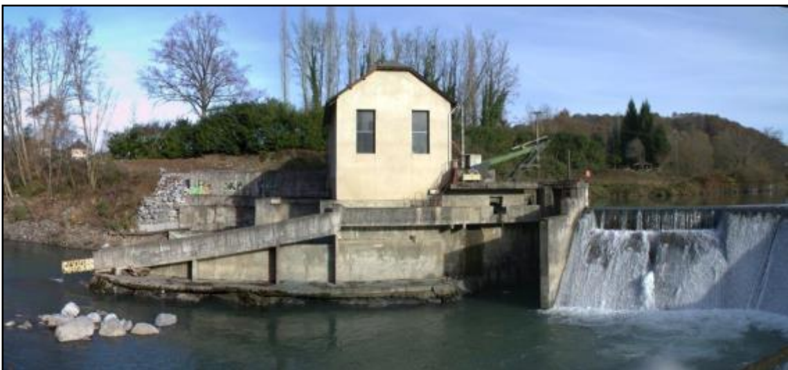
Vue depuis la rive gauche
