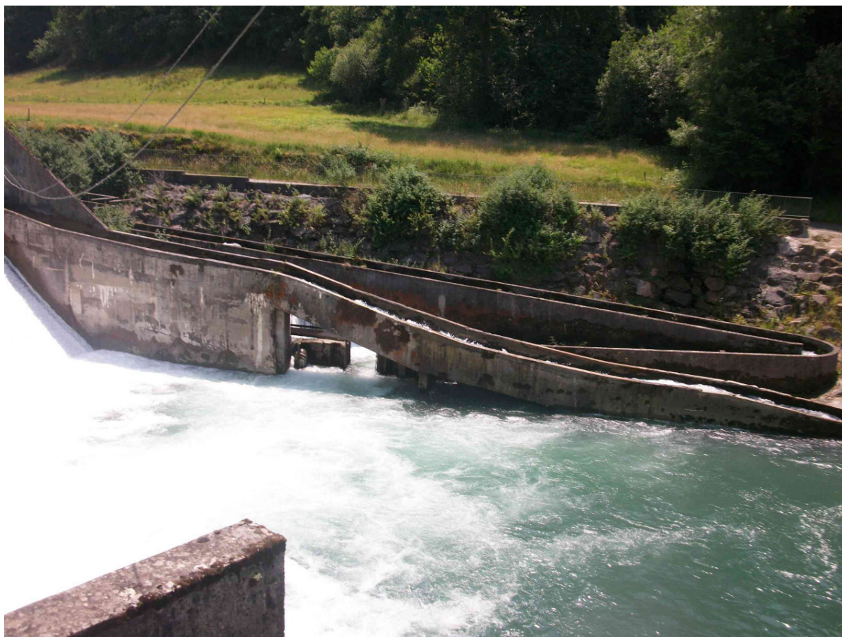
Vue depuis la rive droite : Passe à kayaks et passe à poissons à l'arrière-plan.
