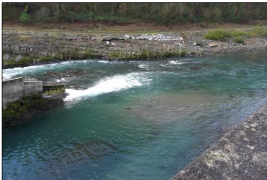
Vue depuis la rive droite – confluence canal de fuite et Gave de Pau (sans turbinage)
