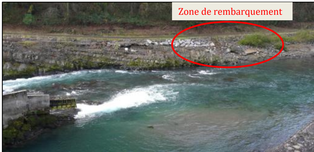
Vue depuis la rive droite, en aval du barrage
