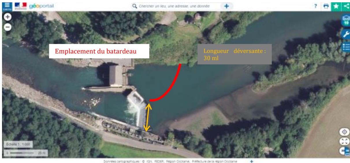
Figure 13 : Emprise du batardeau sur la vue aérienne
