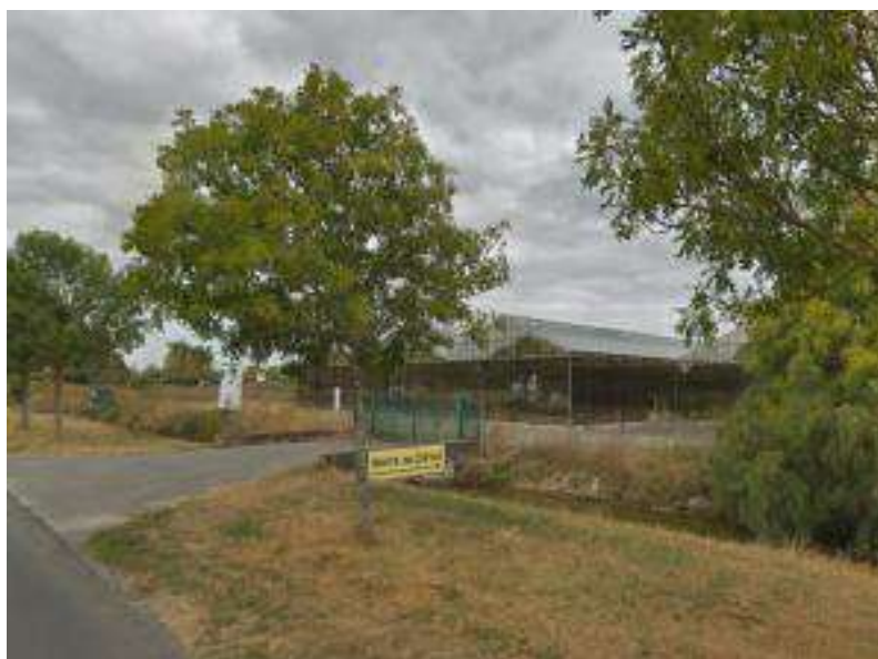
Figure 27. Vue depuis le Sud du site d'implantation
