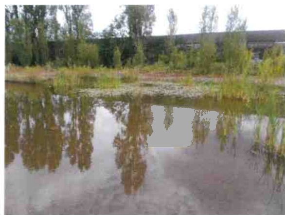
Photo 2 : Plans d'eau temporaires sur sol bétonné (22/05/2018)
