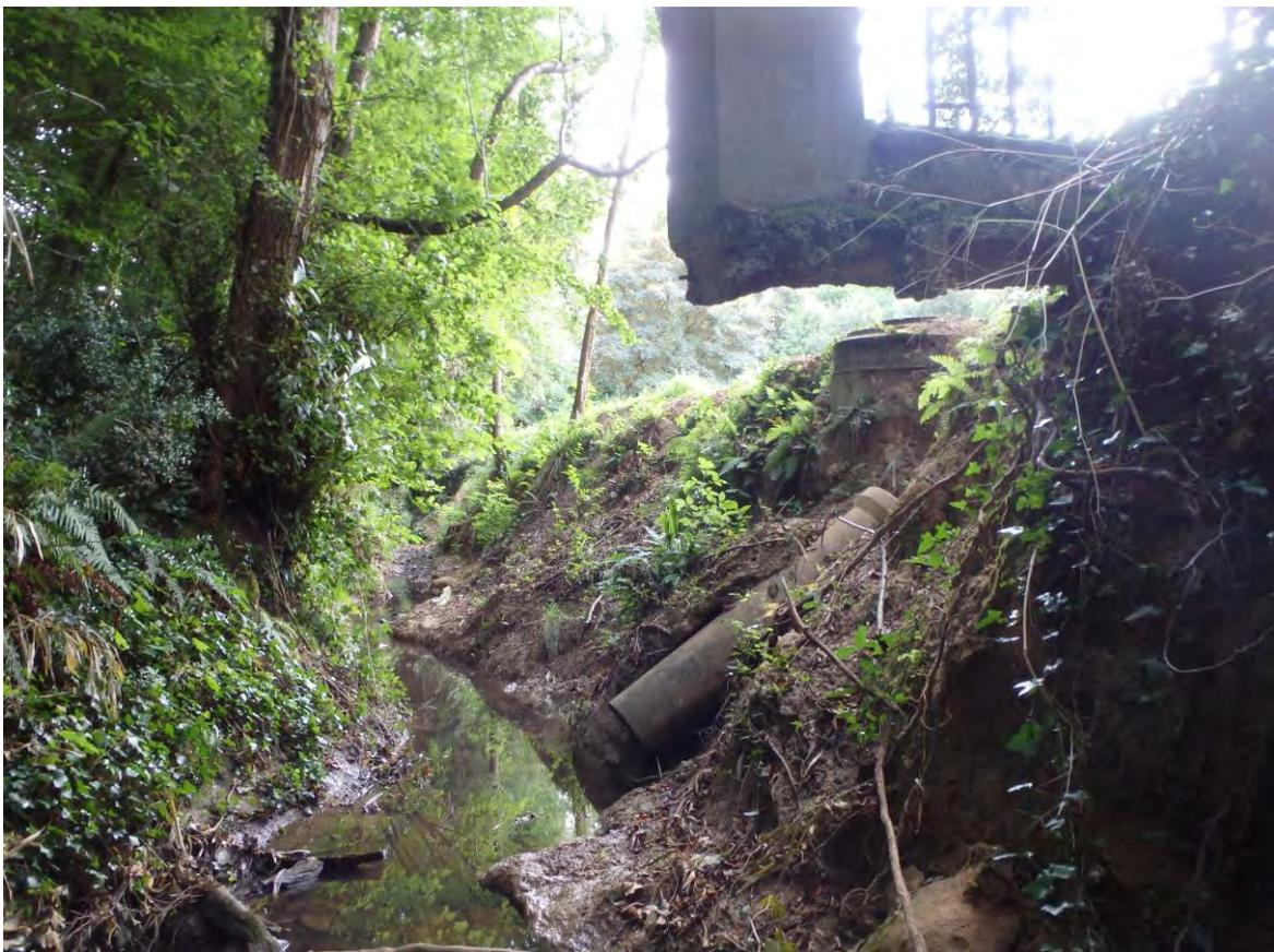
*Figures 1 et 2 : Erosion au niveau de la canalisation d'eau usée - Artigues-près-Bordeaux-8 aout 2018*
