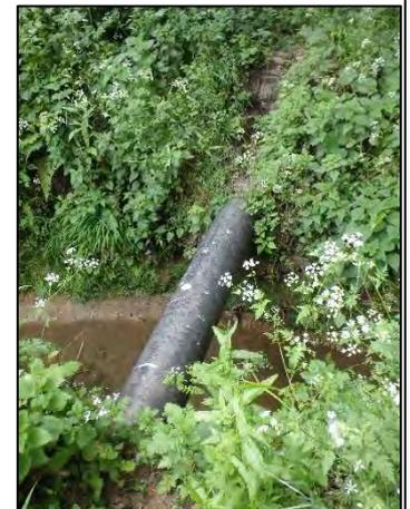
**Photo 8 : Regard et canalisation en travers en péril sur le ruisseau du Fontaudin (Source : SMR Guâ)**
