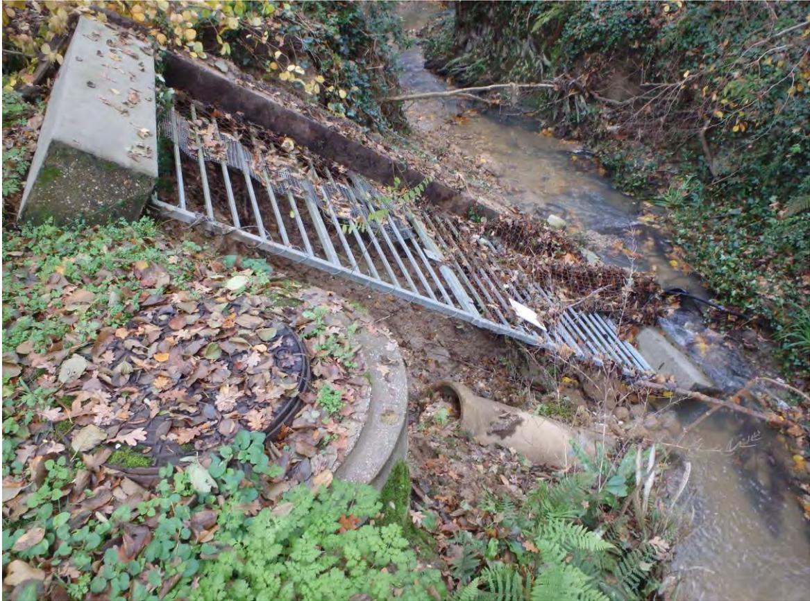
*Figure 3: Erosion au niveau de la canalisation d'eau usée - Artigues-près-Bordeaux- 2 décembre 2019*
