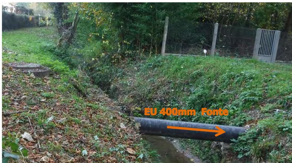
Par ailleurs, **sur toute la durée des travaux, la proximité de ce réseau d'eaux usées et sa sensibilité** vis-à-vis des opérations de terrassement et de la circulation des engins de chantier **constitueront une réelle contrainte.**
