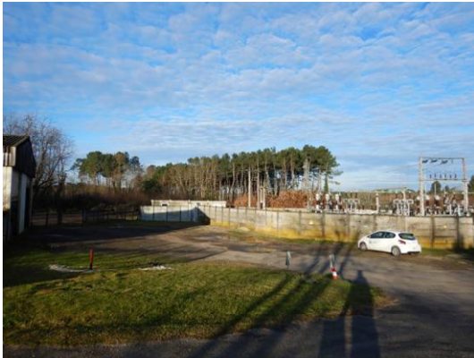
Poste électrique (à droite) et hangar (à gauche)
