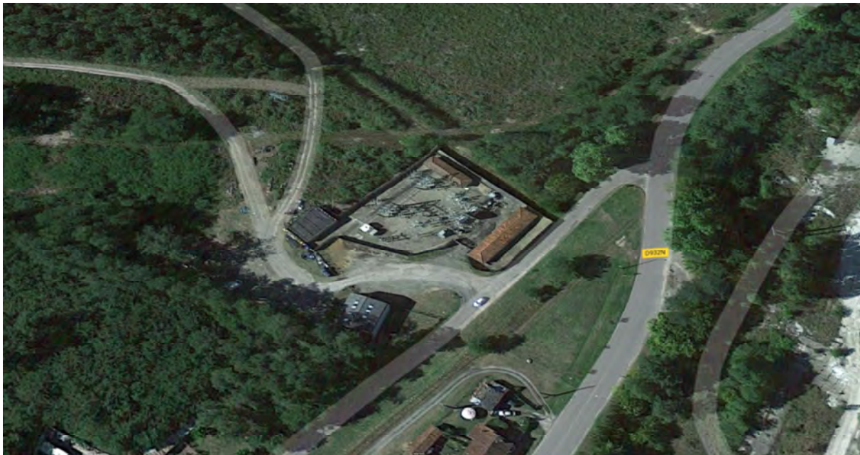
Vue aérienne du poste électrique existant – vue vers le Nord-Ouest (Source : Google Earth)
