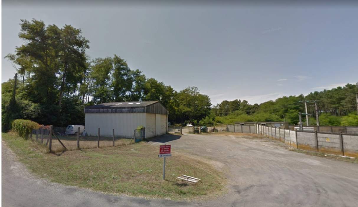
Zone d'extension au Sud – zone d'activité – stockage CDC
