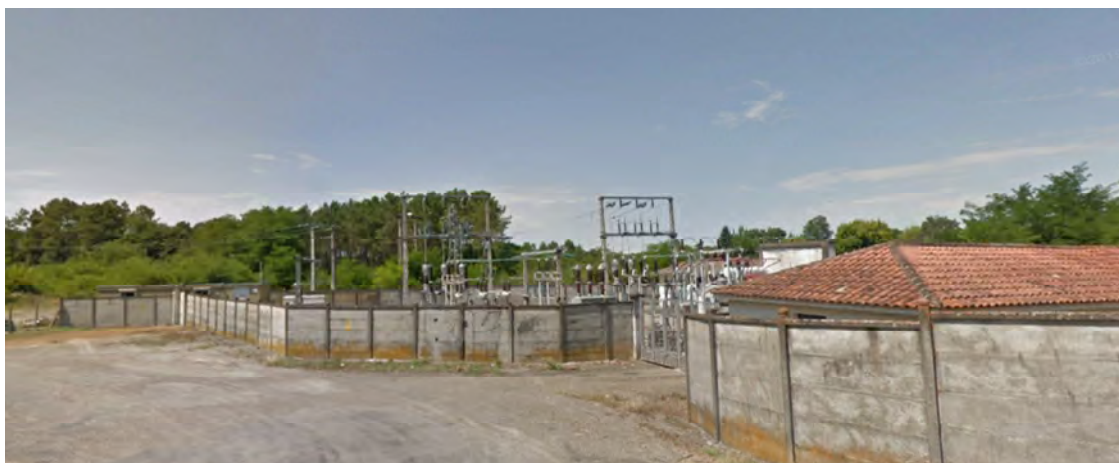
Poste existant ( coté Sud)
