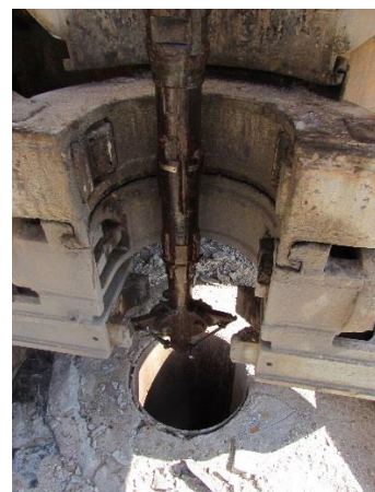
Rebouchage du forage d'irrigation : extraction de 120 ml de tubes PVC sur le forage d'irrigation avant son rebouchage
