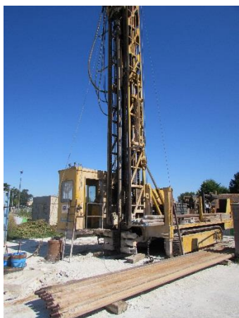
Rebouchage du forage d'irrigation : extraction de 120 ml de tubes PVC sur le forage d'irrigation avant son rebouchage
