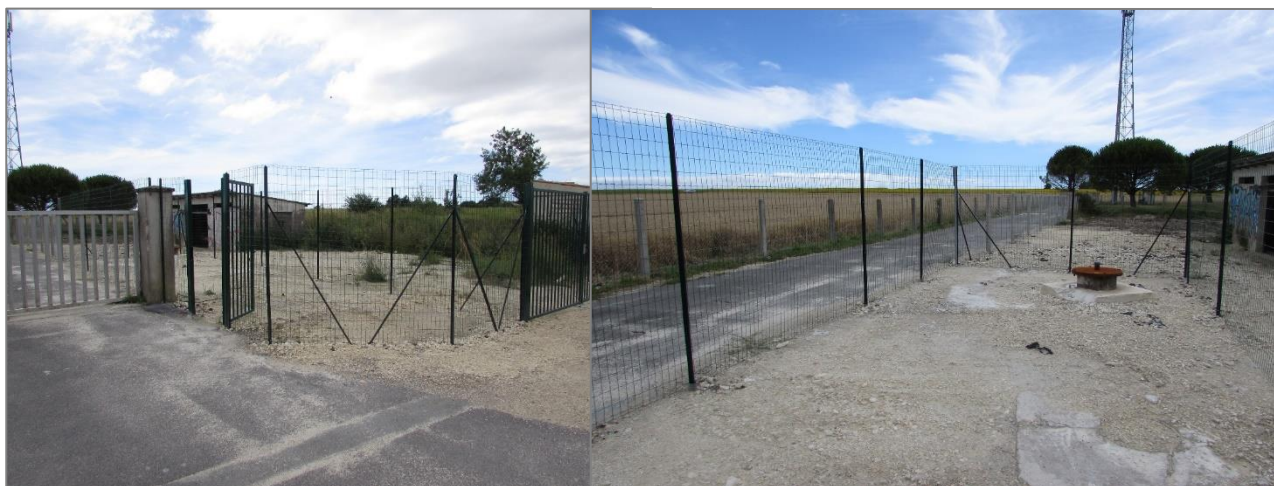
Forage et clôture du périmètre immédiat
