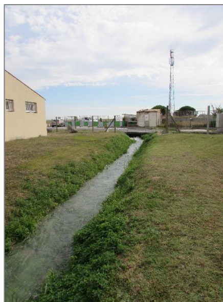
Fossé en aval du captage de Médis (en arrière plan). Rejet des eaux de pompage.
