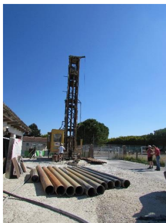
Rebouchage du forage d'irrigation : extraction de 120 ml de tubes PVC sur le forage d'irrigation avant son rebouchage
