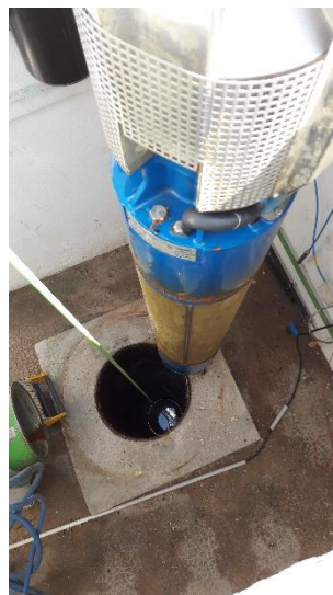
Repose de la Pompe sur « Pompierre P 2 »
