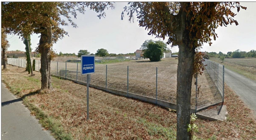
Fossé en bordure du périmètre de protection immédiate du captage de Le Chay « Pompierre » le long de la D17.
