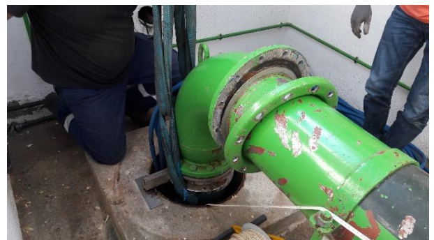
Repose de la Pompe sur « Pompierre P 2 »
