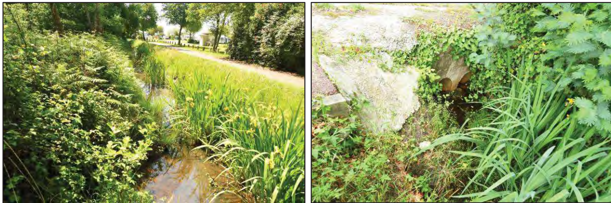
Figure 6 : Illustrations des fossés caractéristiques du périmètre projet, avec la présence d'un passage busé à droite (Source : ENVOLIS)
