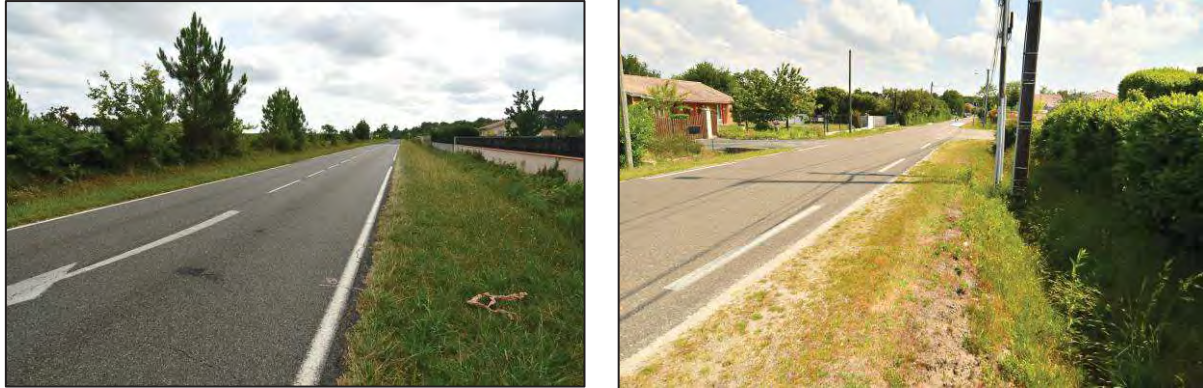
Figure 9 : D652 et Avenue de Lanot (Source : ENVOLIS)
