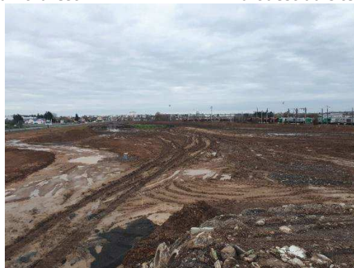
Vu sud depuis le stockage nord-est
