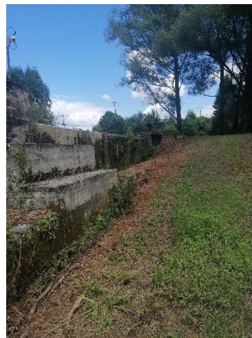
Figure 8: Vue du bassin de mise en charge avec le mur déversoir en rive gauche
