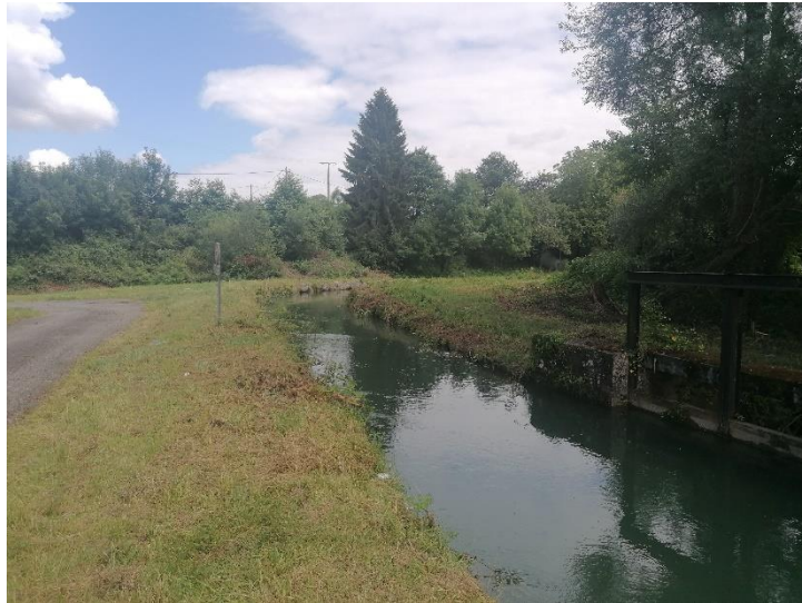
Figure 7: Vue du canal d'amenée – niveau vanne de transfert amont BMC
