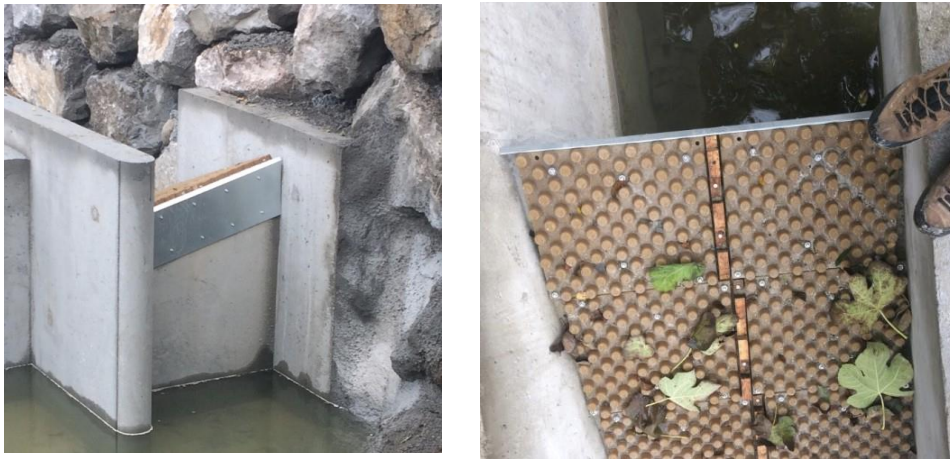
Figure 83: Exemple de cornière amont
