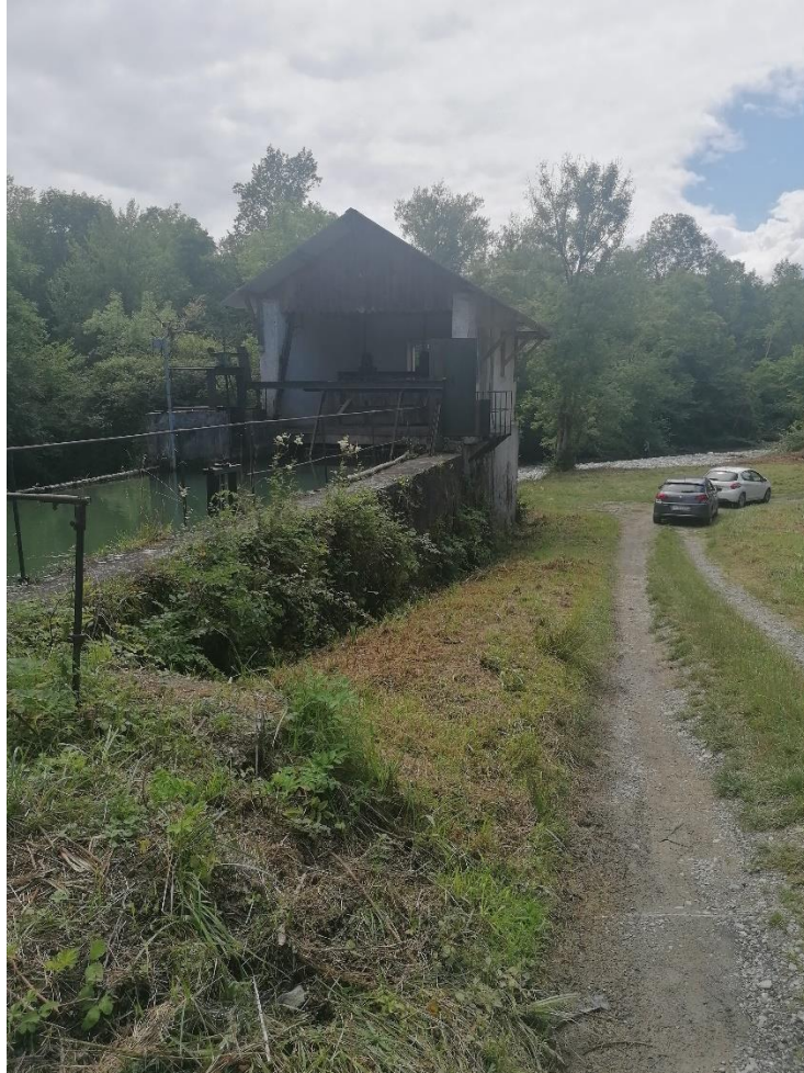
Figure 5: Vue depuis bassin de mise en charge
