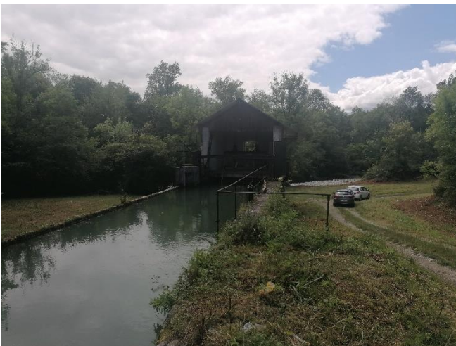
Figure 8: Vue du bassin de mise en charge avec le mur déversoir en rive gauche
