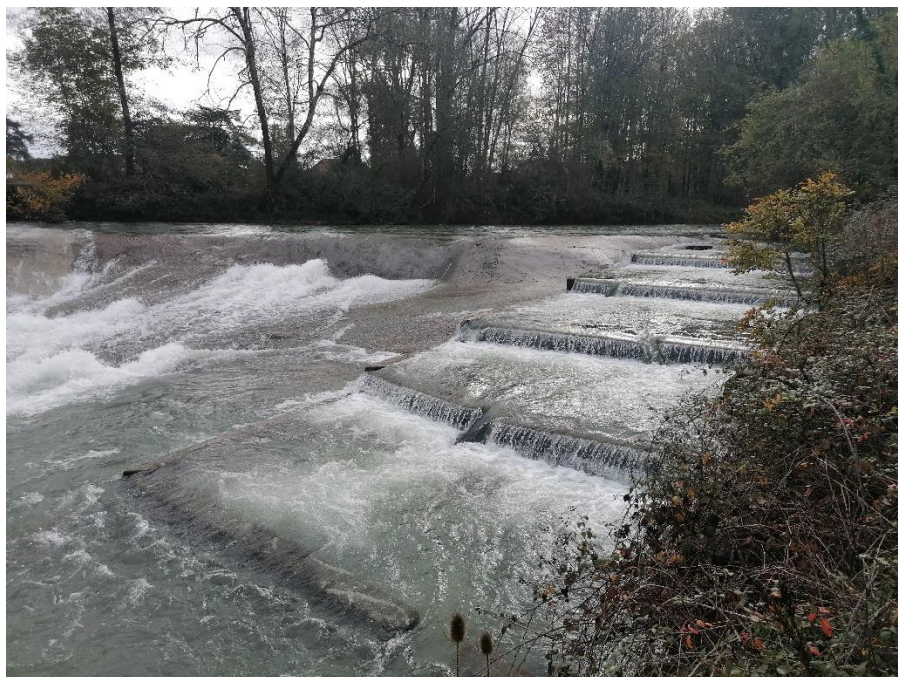
Figure 4: Vue depuis rive gauche
