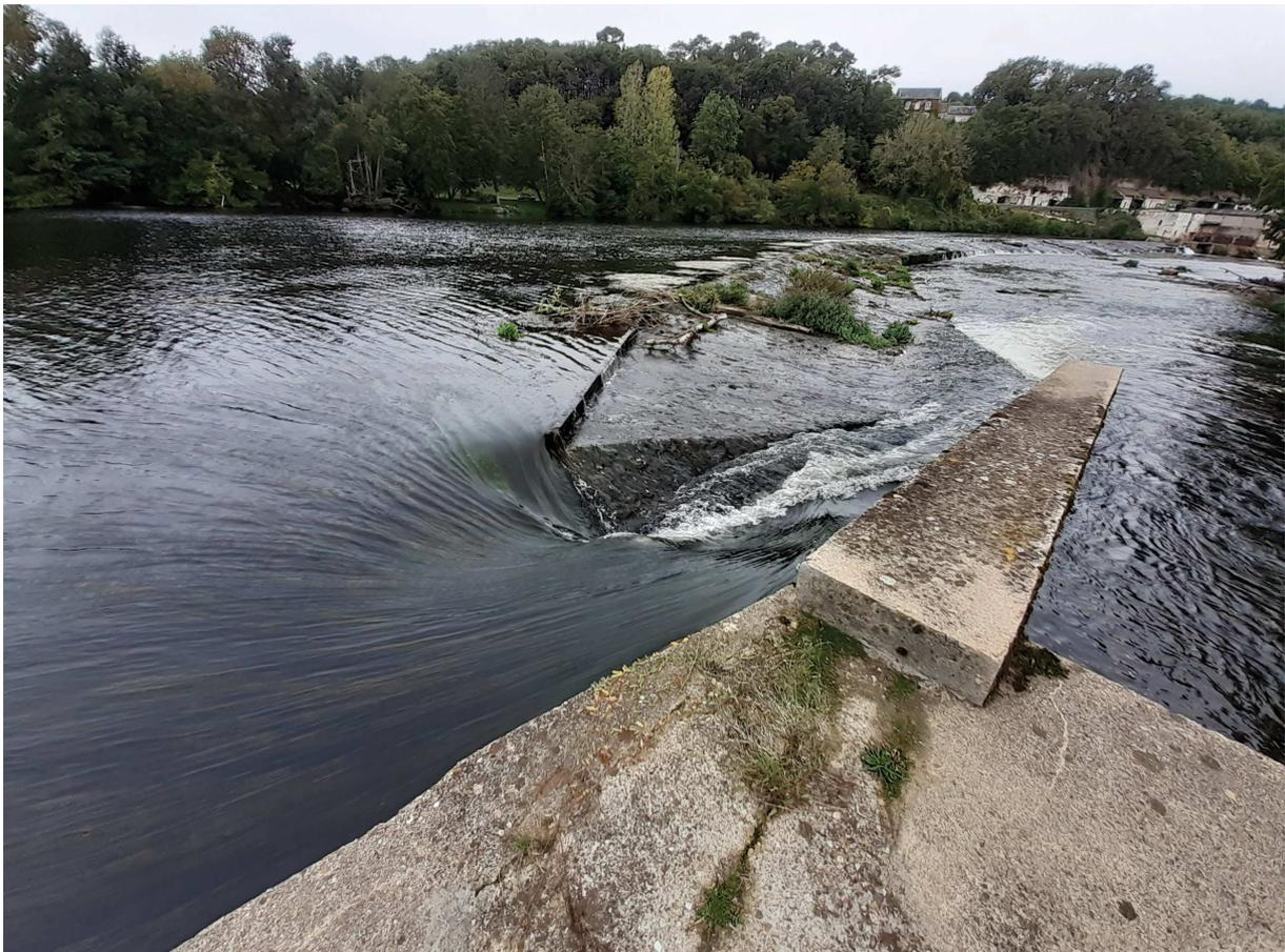
Figure 9 : échancrure de dévalaison en rive droite
