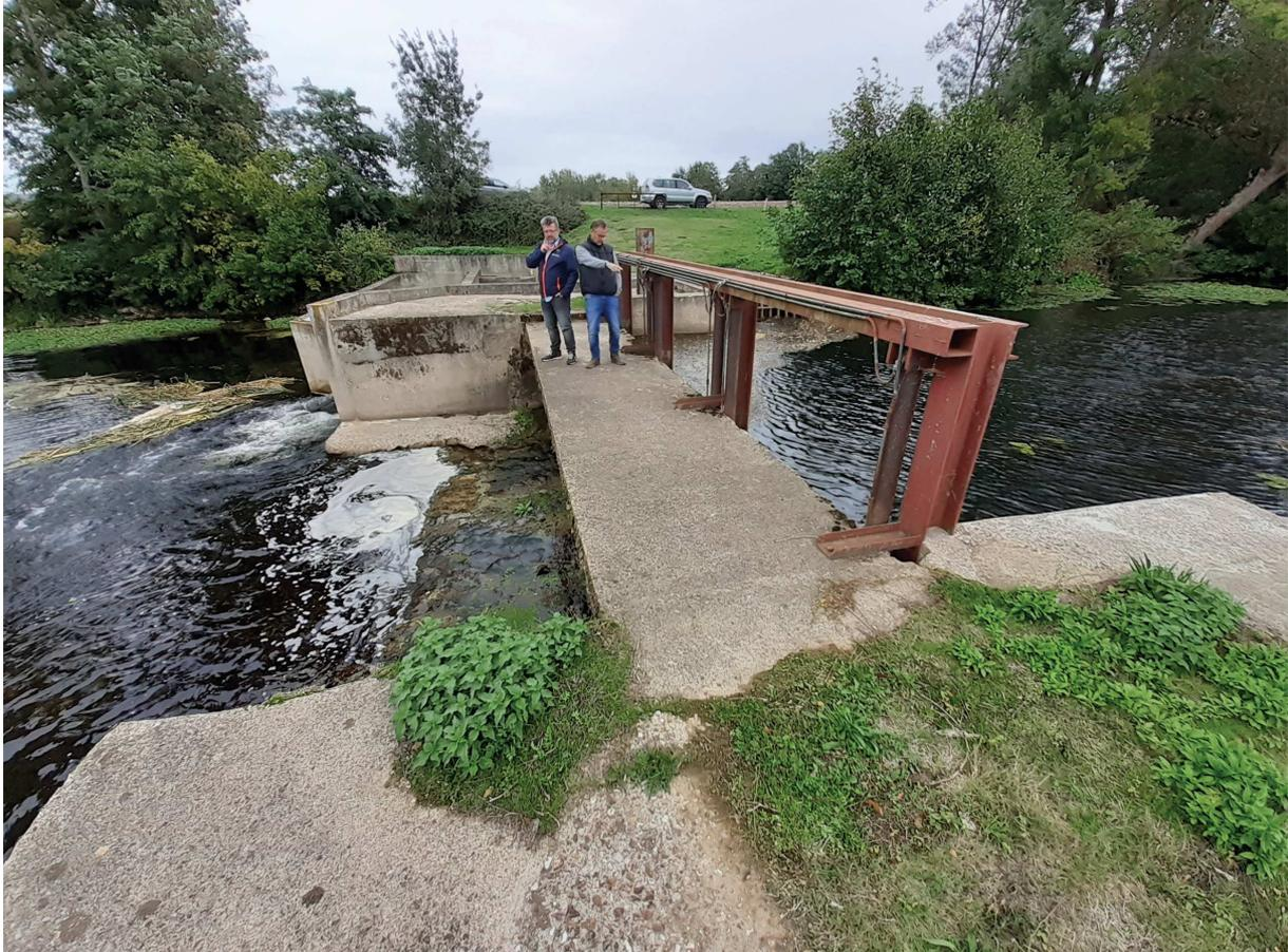
Figure 7 : vannes de décharge droite
