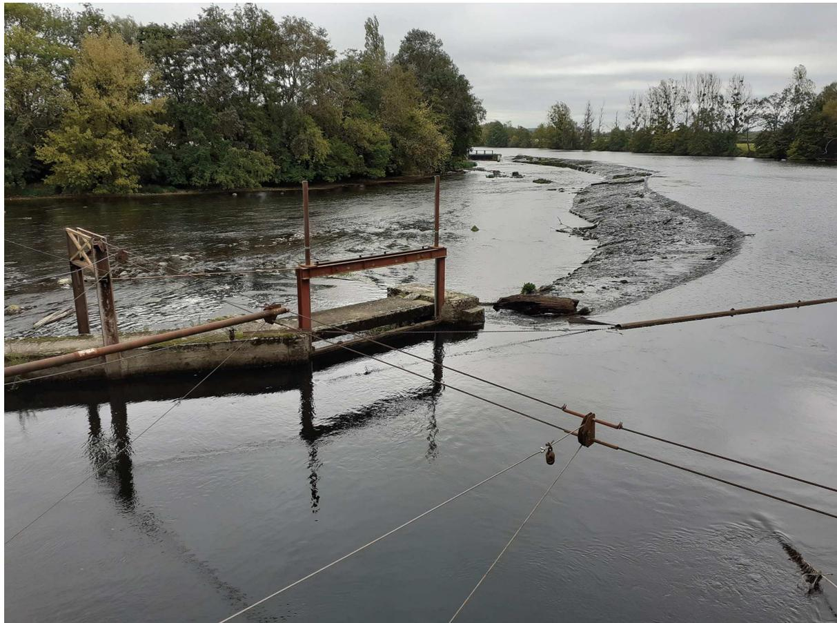
Figure 6 : Vanne de décharge gauche
