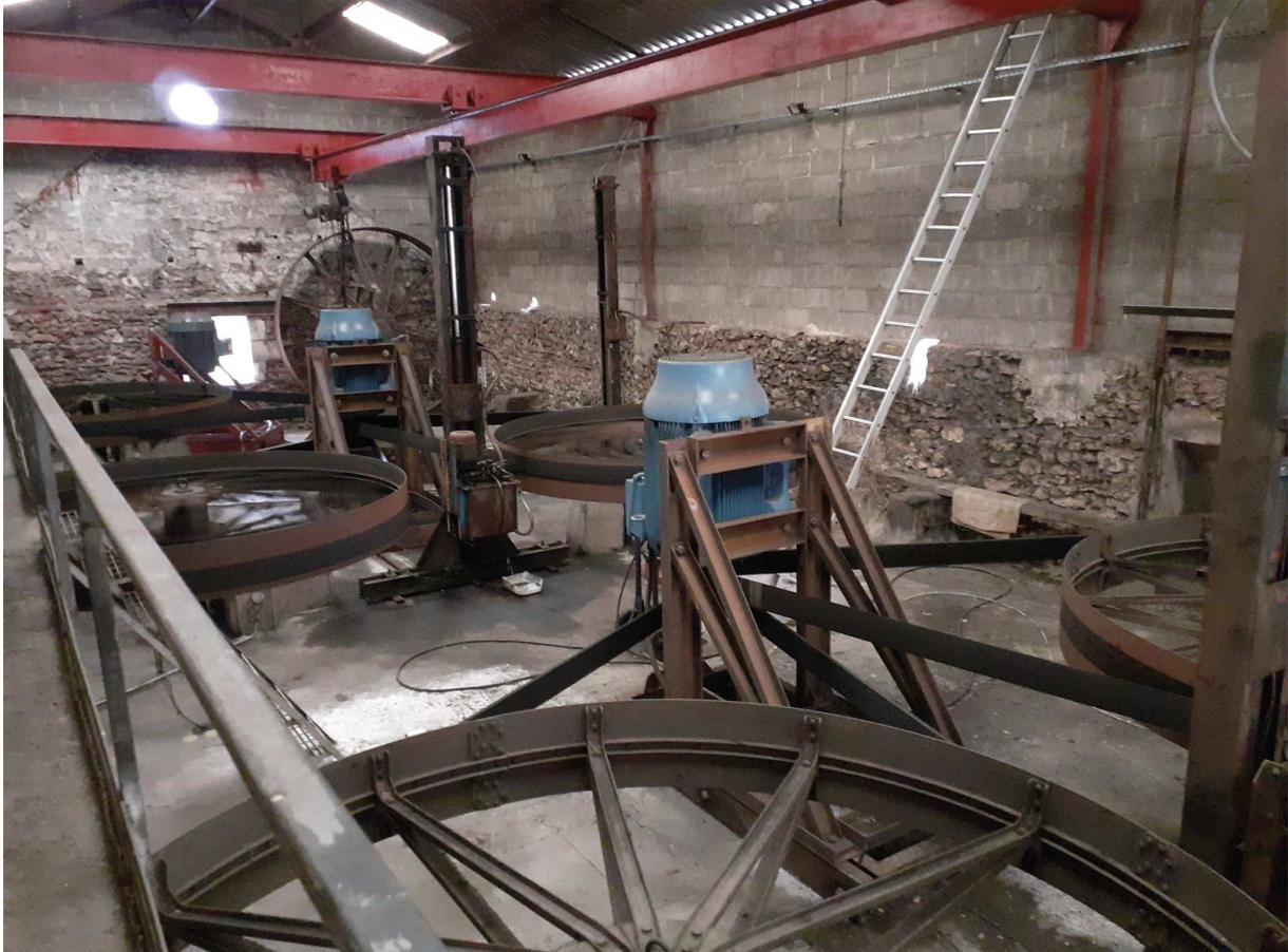
Figure 3 : couplage des turbines aux génératrices électriques
