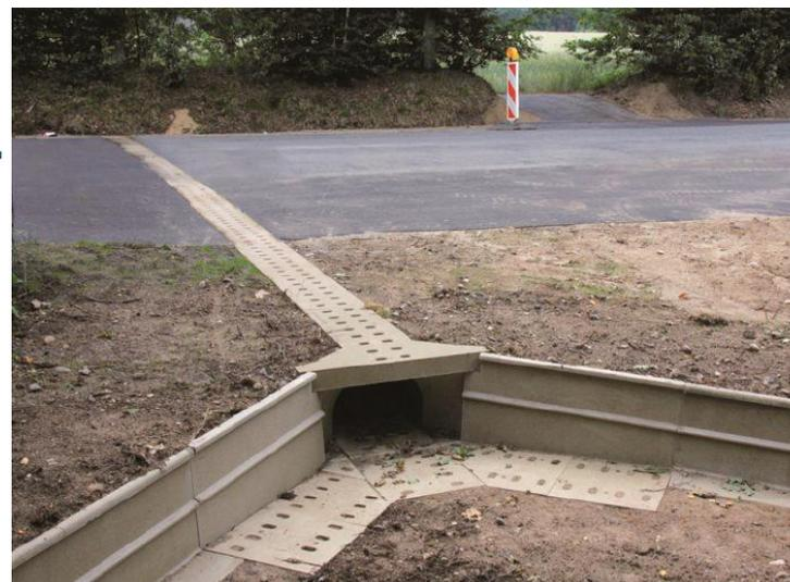
Figure 22 : Localisation du crapauduc à installer (à droite) et exemple de crapauduc (Source ACO Crapauduc)
