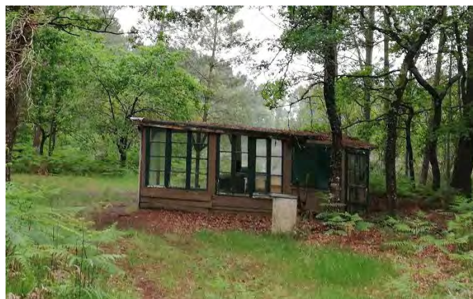
Figure 4 : Photographie du bâtiment existant – Future base de vie (©CERAG)
