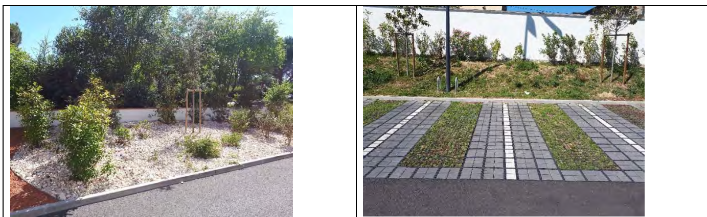
Fig. 17 -Coefficient de ruissellement faible pour les espaces verts xérophiles et les places de parking perméable.
