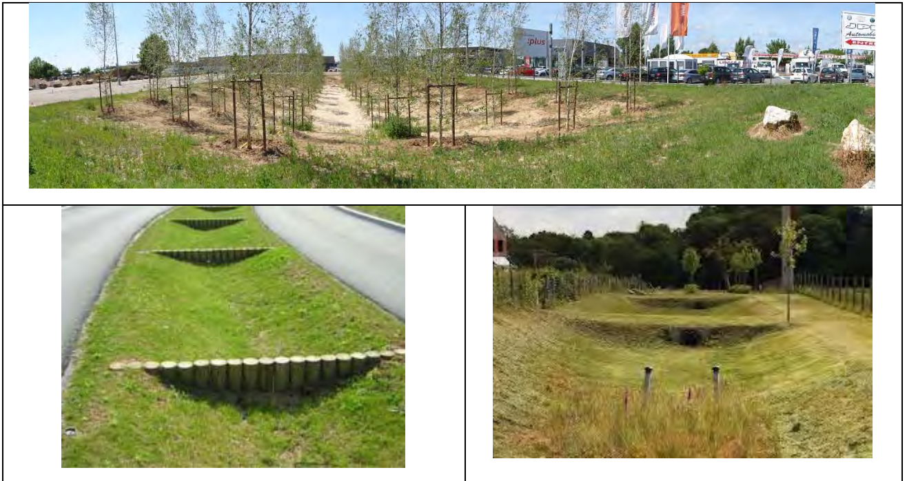
Fig. 19bis - Noes avec ouvrages de sédimentation/ralentissement.
