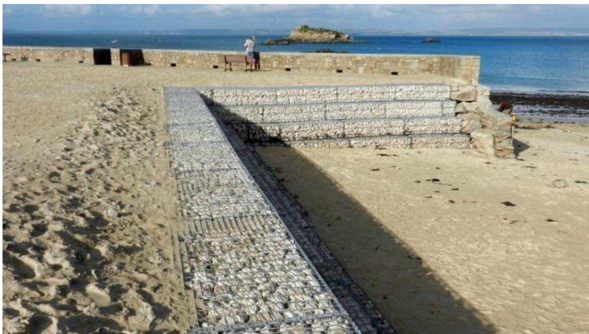
Figure 5 : Exemple de réalisation de murs de soutènements en gabion (source : Sables-Blancs, Brest)
