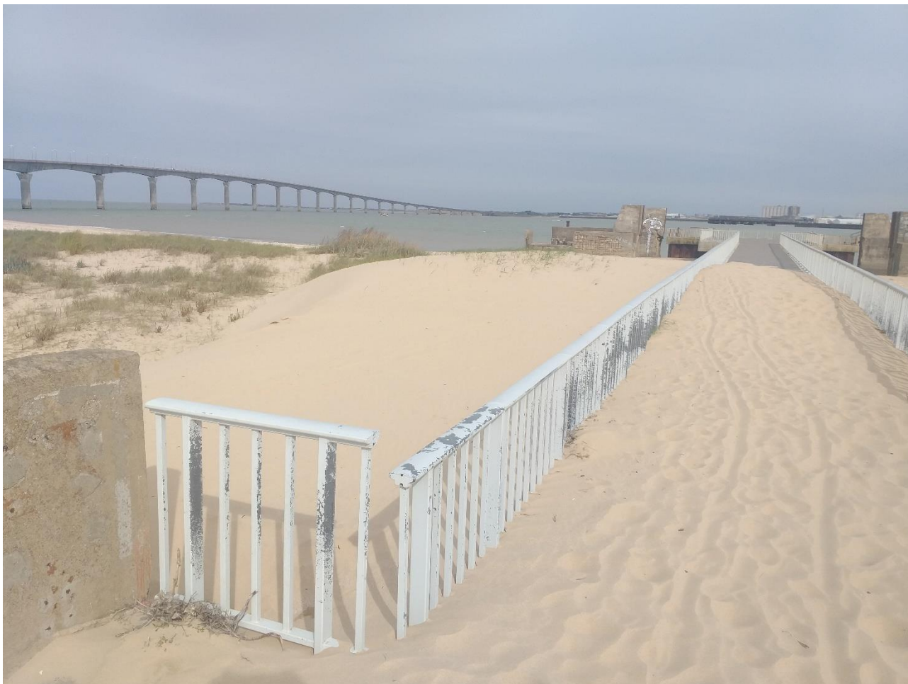
Figure 1 : Photo de la passerelle située sur La Pointe de Sablanceaux
