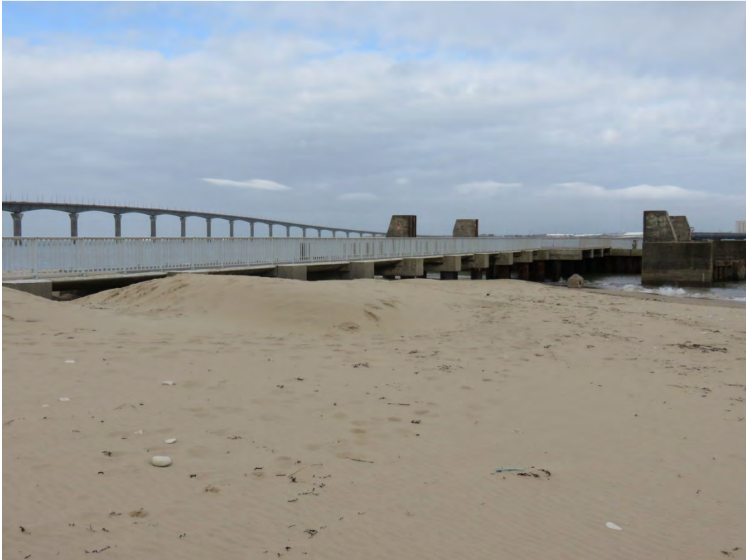
Ensemblement de l'ancien appontement de Sablanceaux
