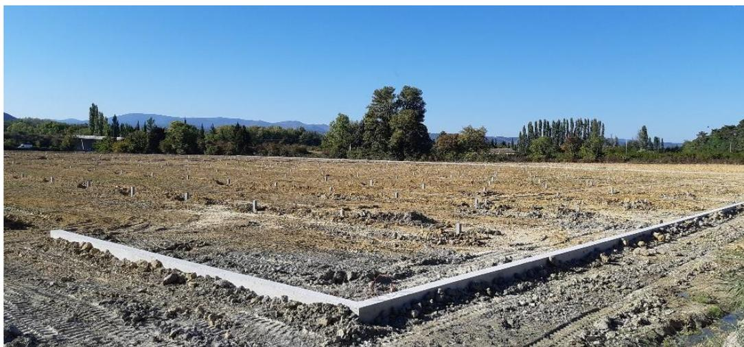
Figure 16 : Exemple de fondations béton extérieures - Source : Reden
