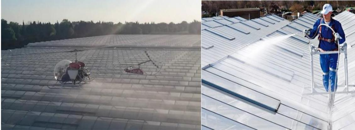
Figure 19 : Exemple de blanchiment de verres
