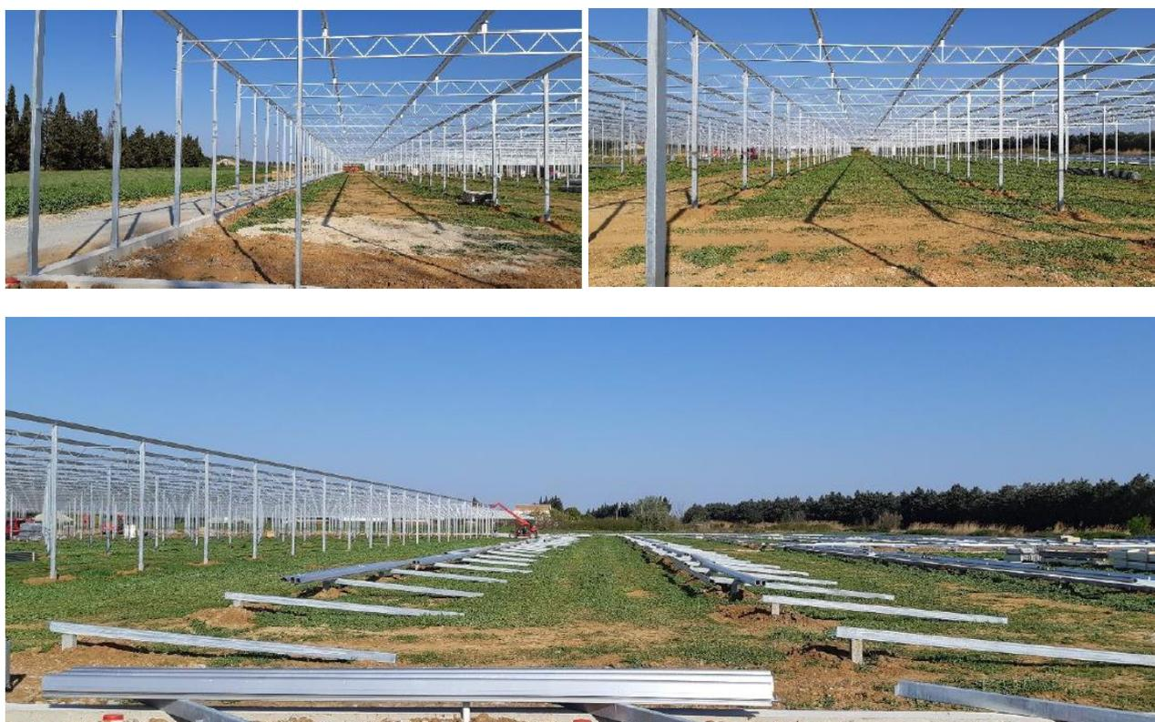
Figure 17 : Montage structure d'une serre photovoltaïque - Source : Reden
