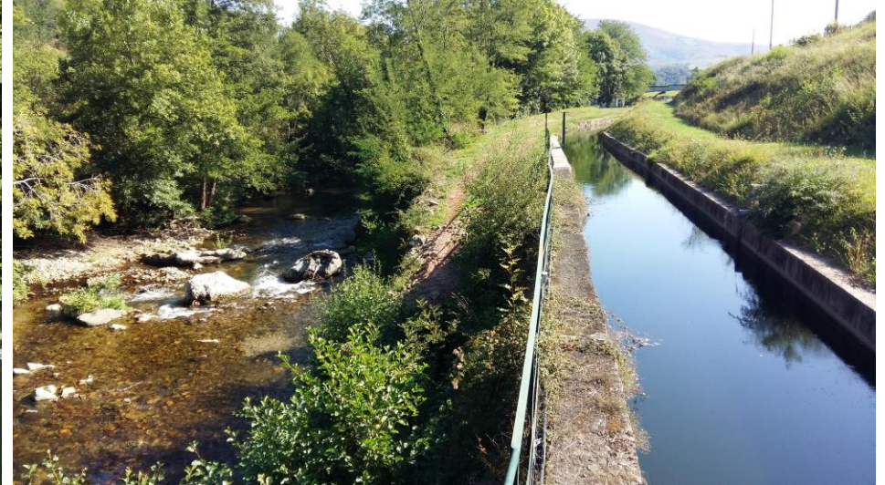
2/ Départ du canal d'amenée
