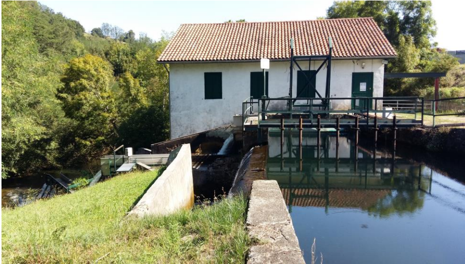
3/ Bâtiment usine et dispositif de dévalaison (côté gauche)
