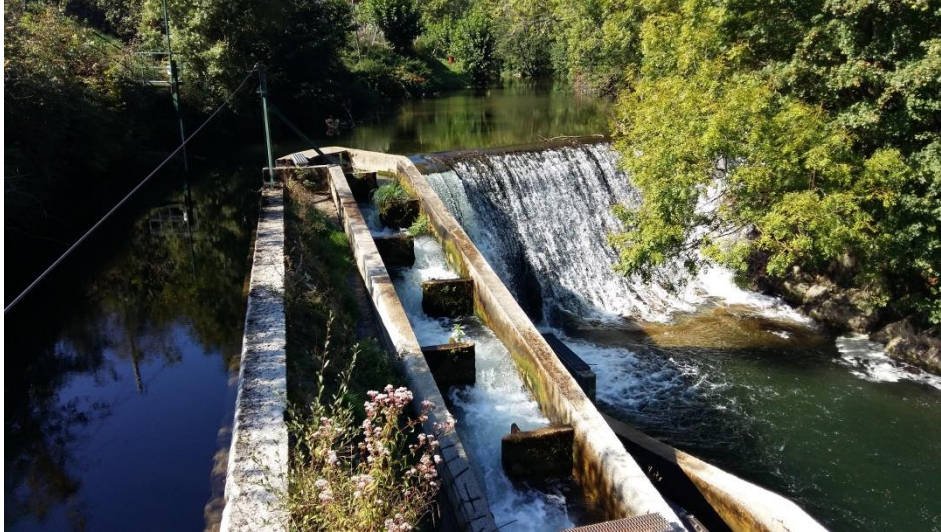
1/ Barrage, prise d'eau et passe à poissons actuelle (à modifier)
