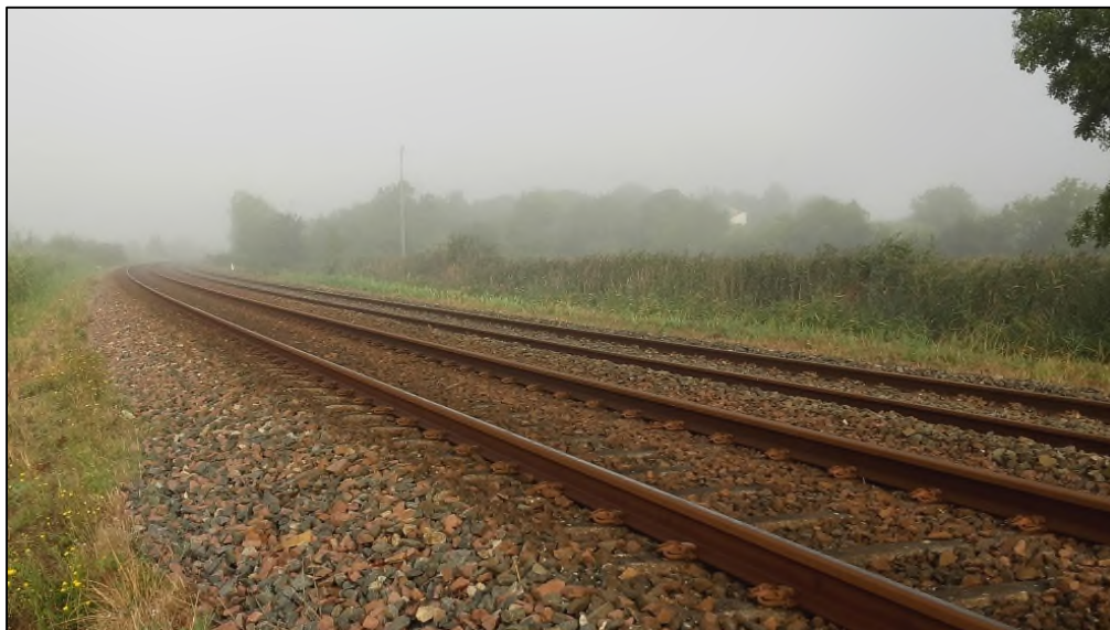
Figure 12 : Illustration de la voie ferrée en activité
