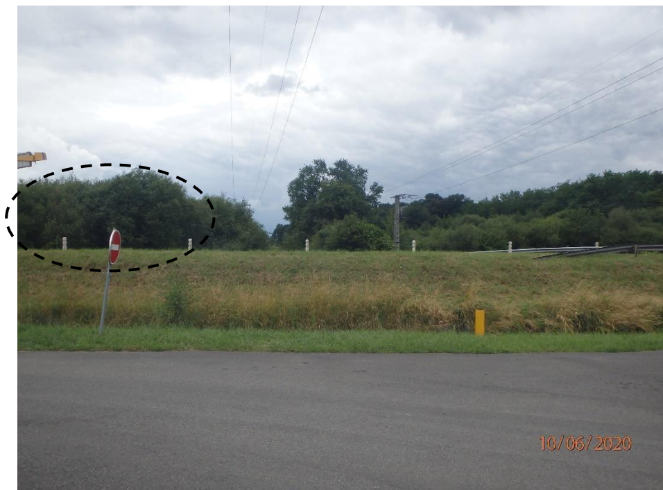
Photo 1 – Vue depuis la voirie d’Eurolacq 2 vers le secteur d’implantation (voirie existante-accès A64) du giratoire et lignes Haute Tension)
