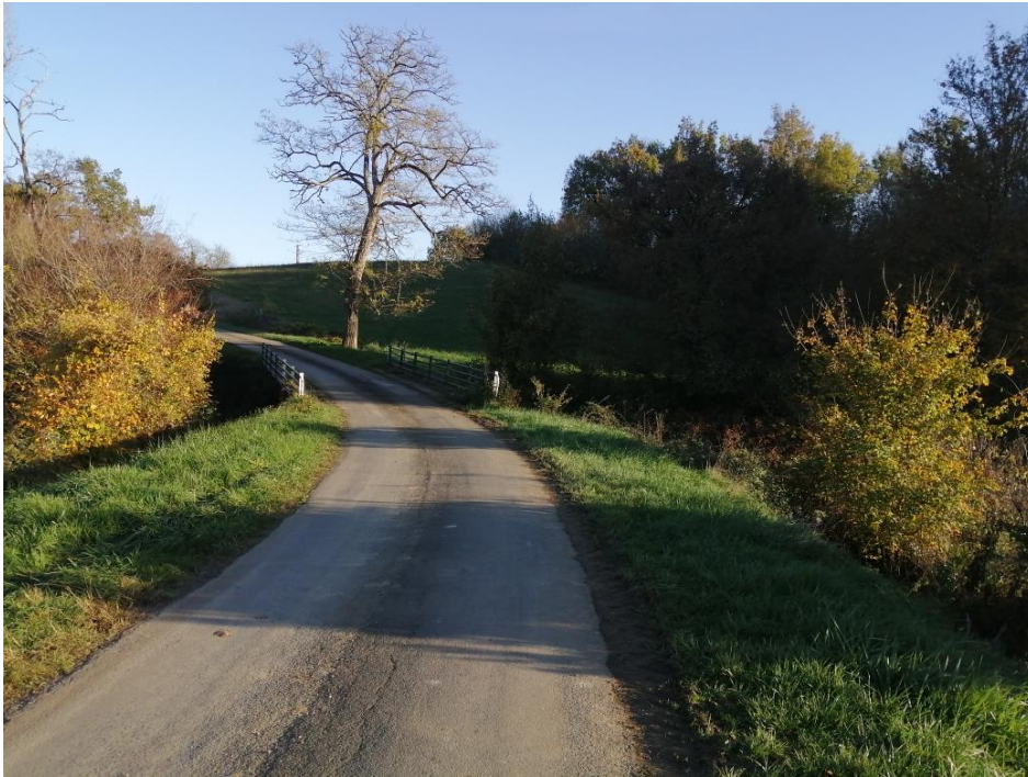
Figure 34 : Vue sur le pont sur lequel va être fixée la canalisation
