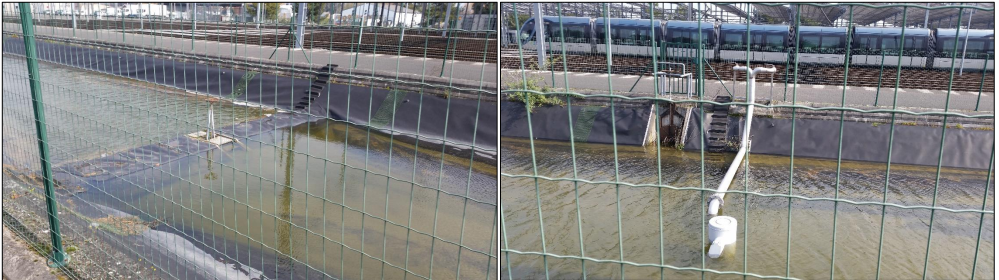
Figures 3 et 4 : Photographies des installations présentes le long du bassin
