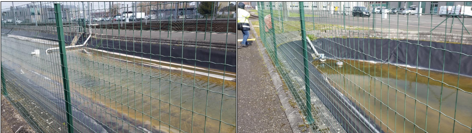
Figures 5 et 6 : Photographies des installations présentes le long du bassin (à gauche) et à l'extrémité nord (à droite)
