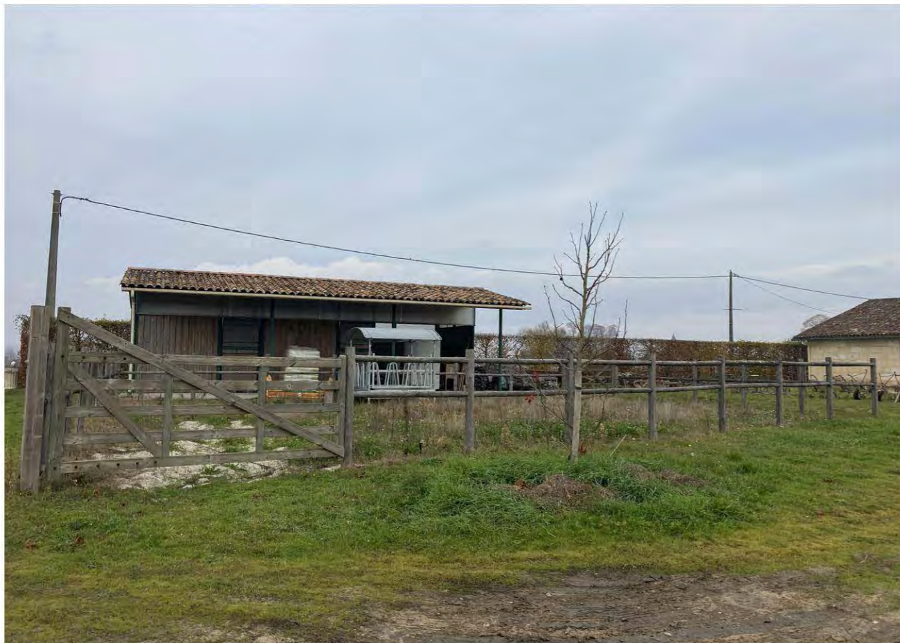
2. Photo des boîtes à démolir (façade Sud) depuis le chemin d'exploitation
