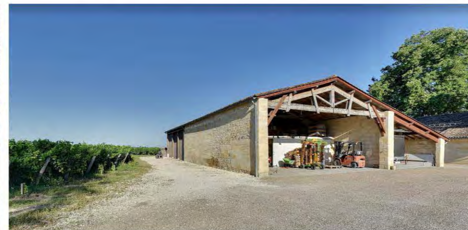
6. Photo du bât. 5 - garage façades Sud et Est
