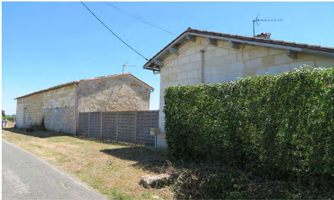
1. Photo du pôle viticole façade Nord, depuis la voie communale n° 128
