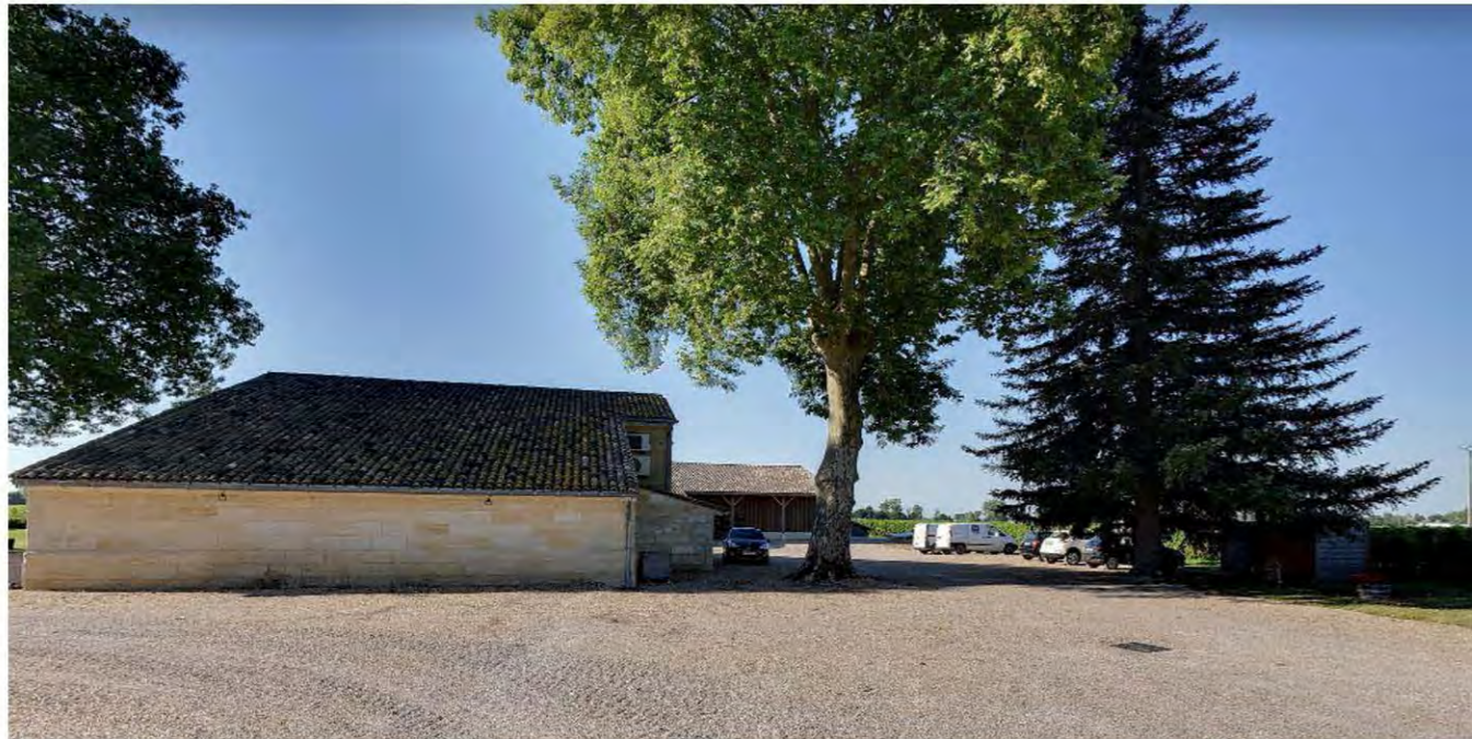
1. Photo du bât. 4 - stockage façade Nord
