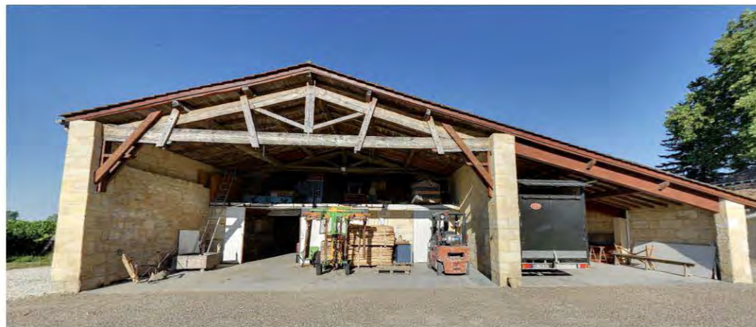
5. Photo du bât. 5 - garage façade Est
