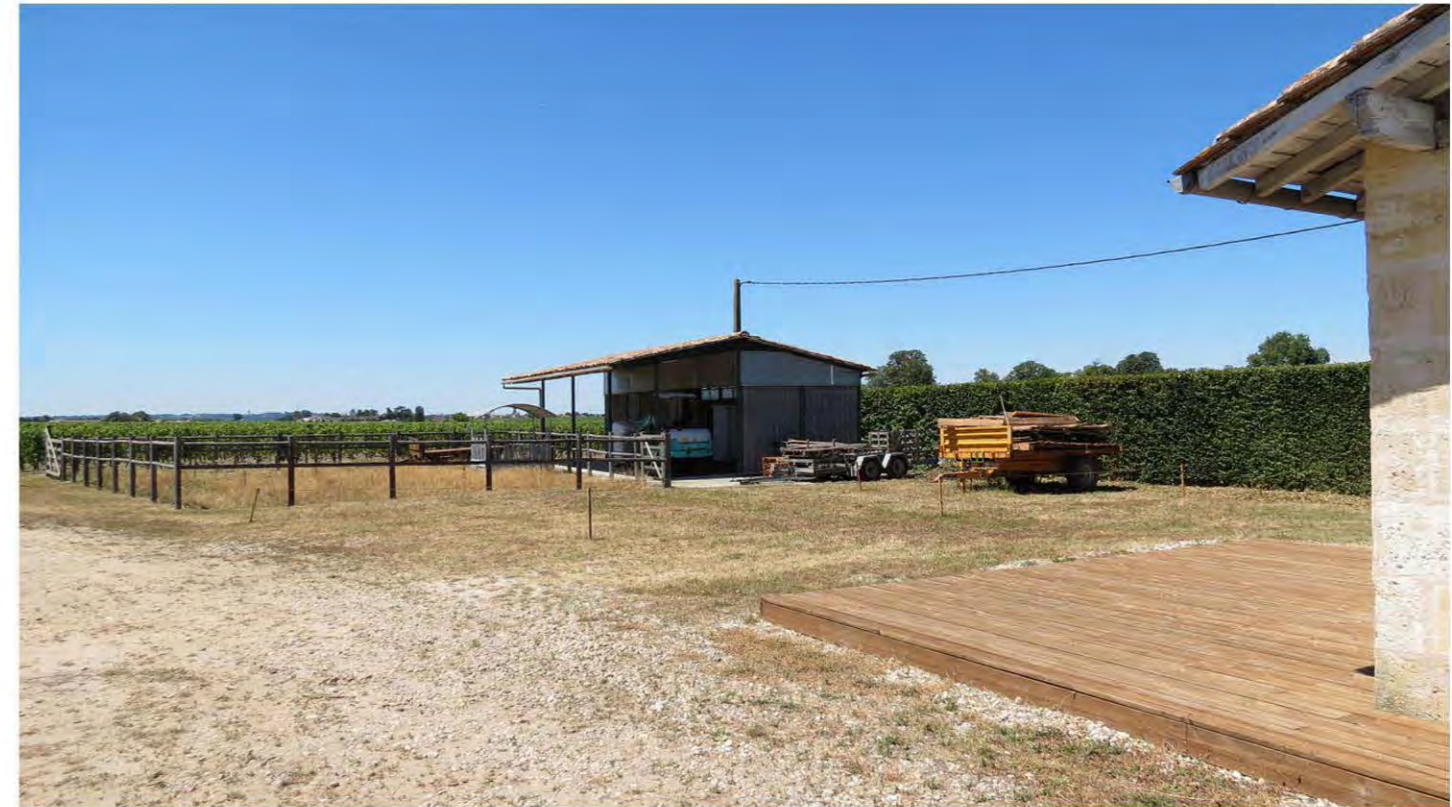
4. Photo du pôle viticole façade Sud-Est, depuis la voie communale n° 128
