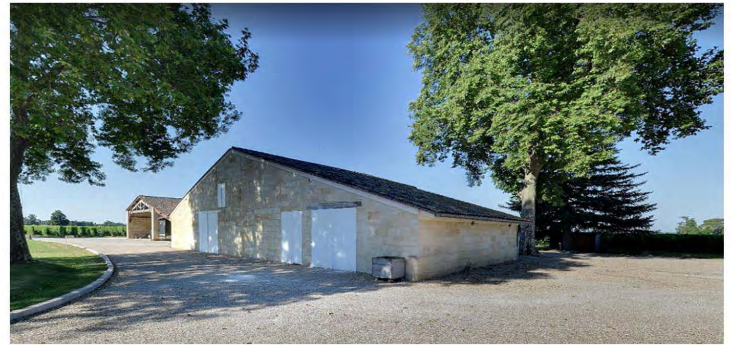
2. Photo du bât. 4 - stockage façade Ouest
