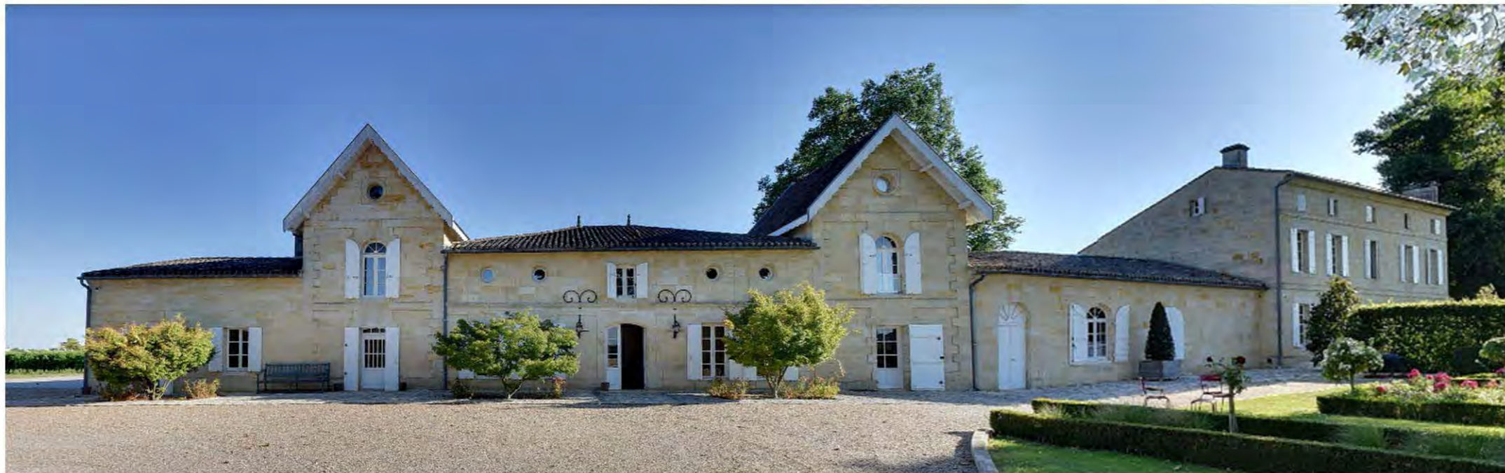
1. Photo panoramique du bât. 2/3 - château façade Sud
