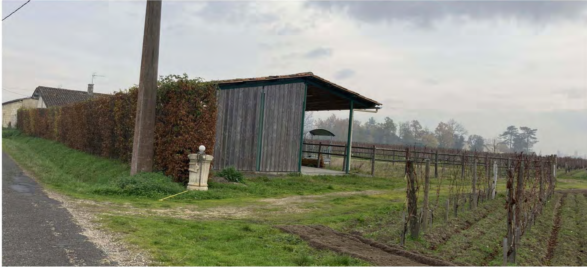
1. Photo des boîtes à démolir (façade Ouest) depuis la voie communale n°128
