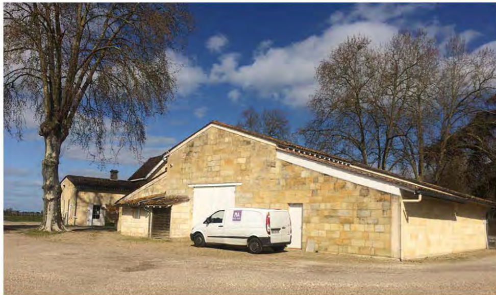
3. Photo du bât. 4 - stockage façade Ouest
