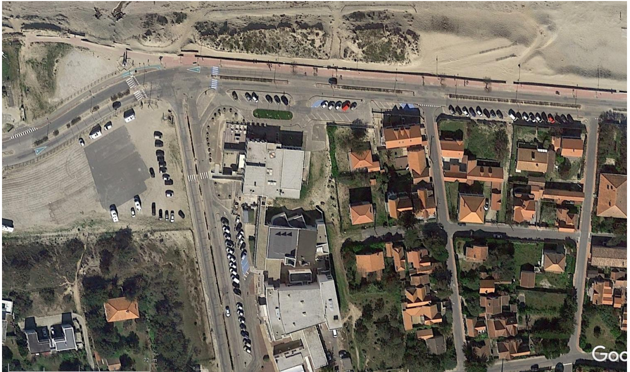
Figure 7 : Photographie aérienne de l'aménagement avant travaux (portion 1) (Source : Google earth)
