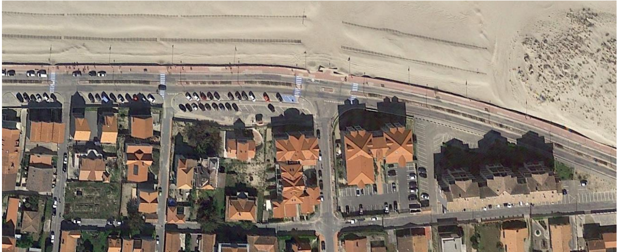
Figure 13 : Photographie aérienne de l'aménagement avant travaux (portion 3) (Source : Google earth)
