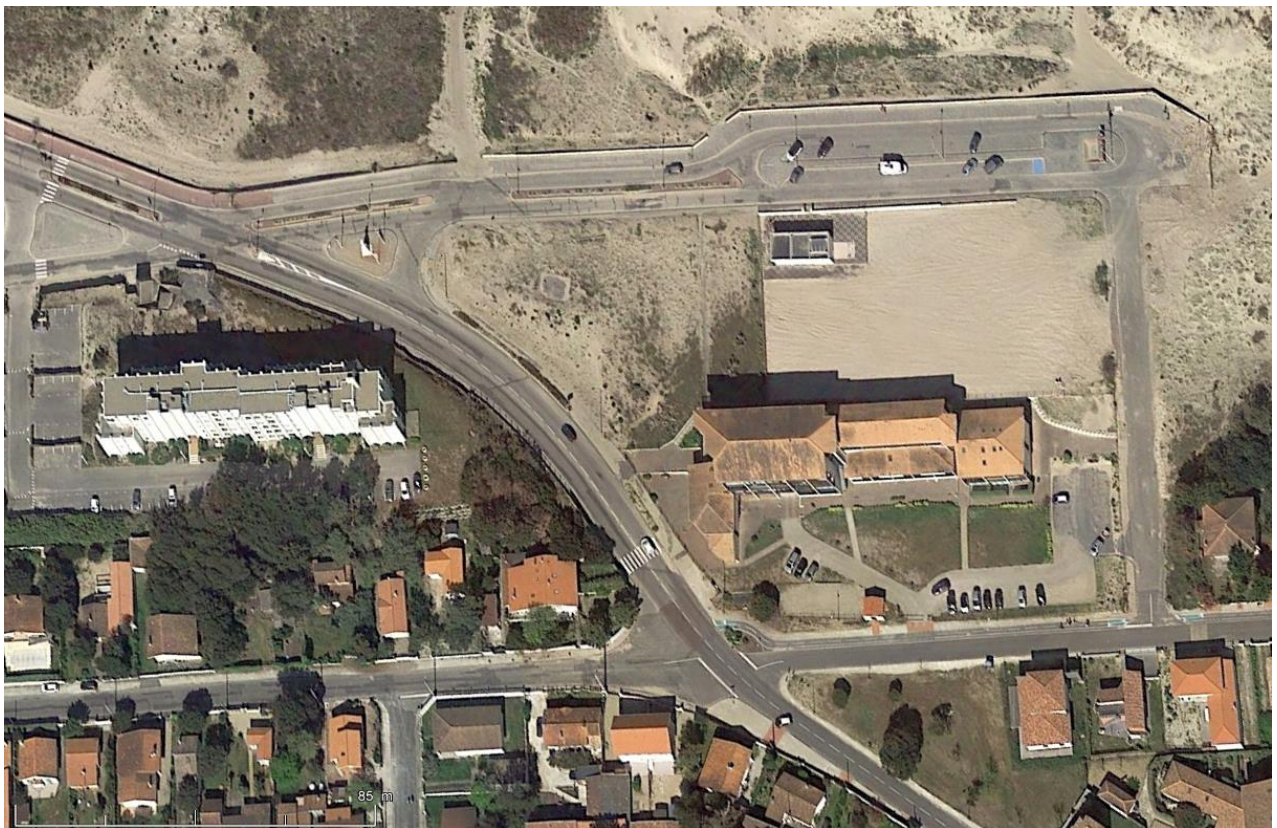
Figure 19 : Photographie aérienne de l'aménagement avant travaux (portion 5) (Source : Google earth)
