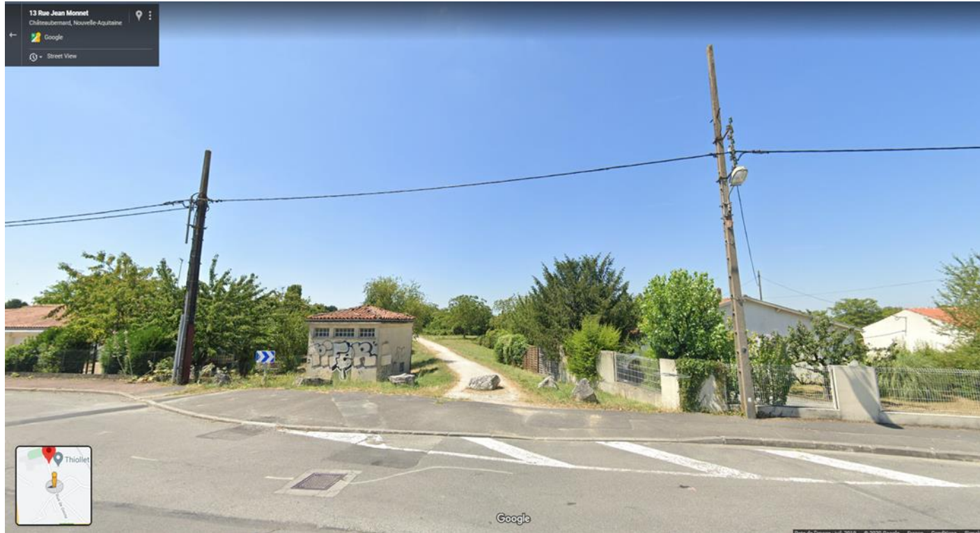
Photographie n°6 : vue de l'emprise de la future voie. Direction Ouest Cheminement doux et poste de transformation Parcelle BA 76.
