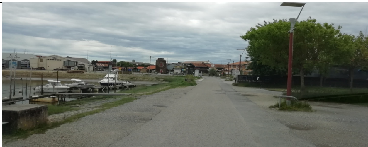
1 : Vue générale du site et de son environnement depuis la voie limitrophe en direction du Sud (04/2020)
