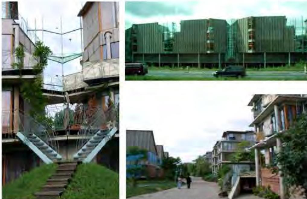
Projet *Nutbeschlange* (Postdam – Allemagne) avec un agencement de bâtiment créant un écran antibruit à quelques mètres seulement d'une autoroute.
