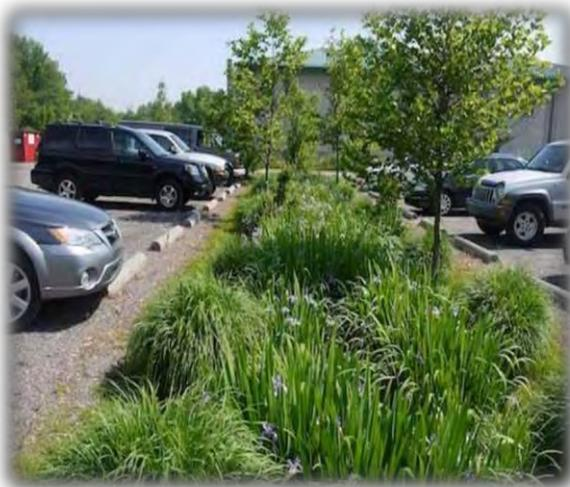
La fonction essentielle de la noue est de stocker un épisode de pluie, le plus souvent décennal mais peut également servir à écouler un épisode plus rare de type centennal. Le stockage et l'écoulement de l'eau se font à l'air libre, à l'intérieur de la noue.
