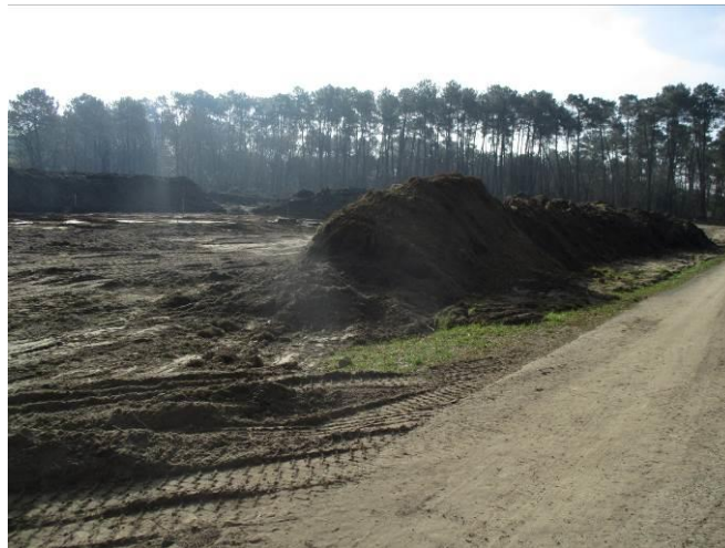
Zone en cours de travaux ©ETEN Environnement
