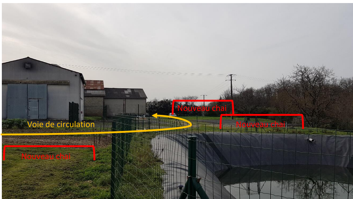
Photo n°5 : Localisation des ouvrages de traitement des eaux accidentelles et EP – Prise de vue 2
