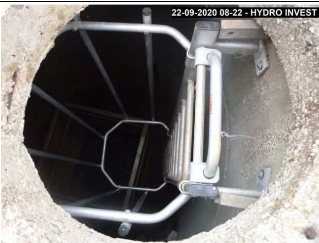
Photo N°5 Echelle d'accès au plancher du puits.
