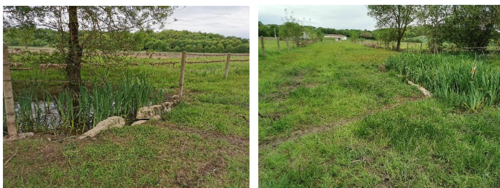
Figure 24 : Vue de la buse à réhabiliter (Source : Eau-Méga, avril 2021)
