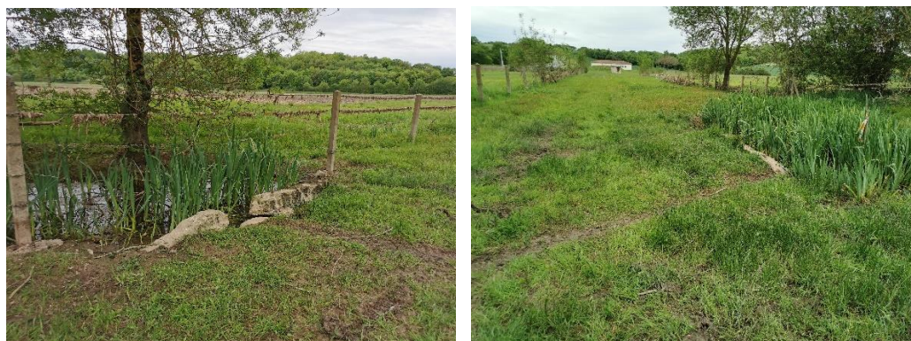
Figure 1 : Vue de la buse à réhabiliter (Source : Eau-Méga, avril 2021)
