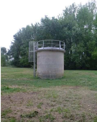
Photo N°1 Vue globale du puits P3
