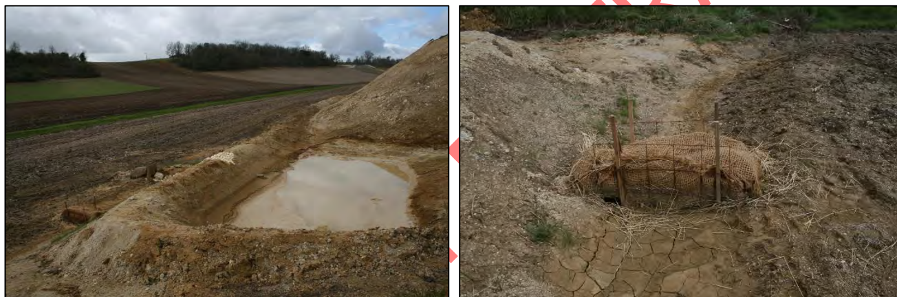
Figure 12 : Bassin de décantation temporaire des eaux de ruissellement en phase de chantier avec filtre à paille en sortie
