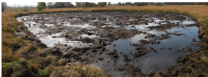
Figure n° 42: étrépage de surface pour création d'un zone humide
