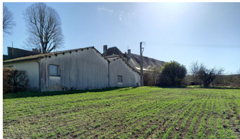
B) Vue terrain arrière ancien centre de secours
