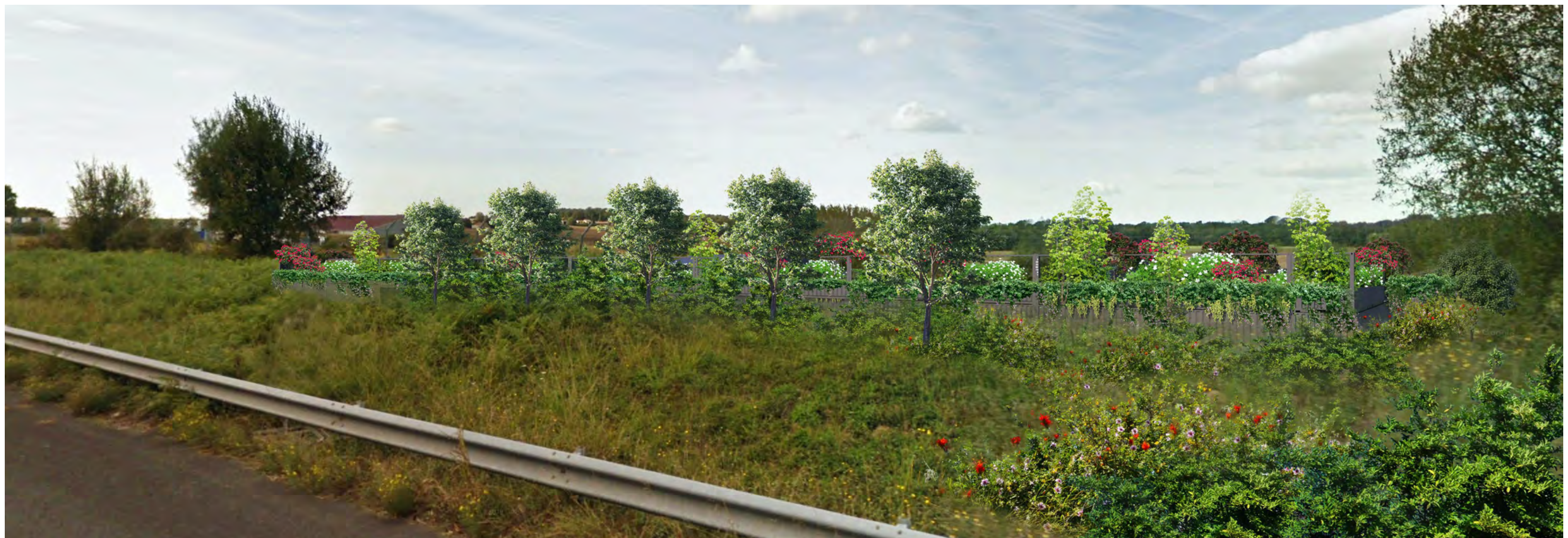
VUE DU PROJET DEPUIS LA DEPARTEMENTALE
