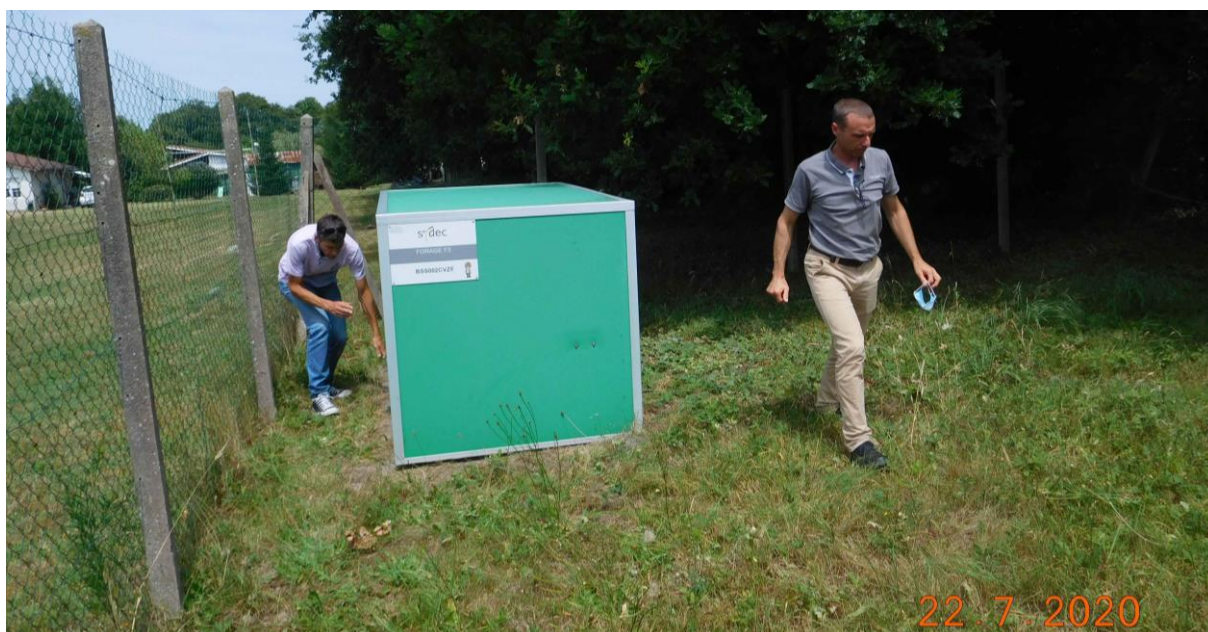
Figure 19. Position du forage F3 dans le PPI et coffre de protection de la tête de forage
