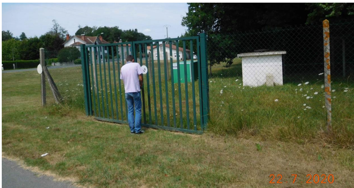
Figure 18. Périmètre de protection immédiate PPI et portail d'accès. F3 à gauche, F1 à droite
