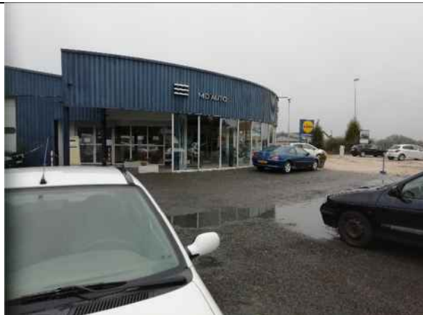
Chemin du clos du bois, entrée du garage automobile [7]
