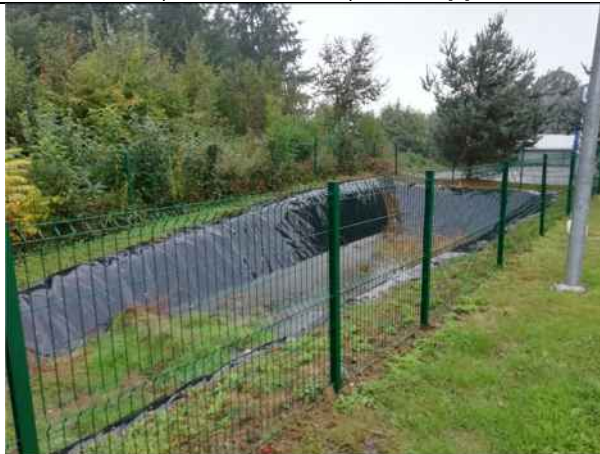
Bassin étanche en limite sud-est de la parcelle [6]
