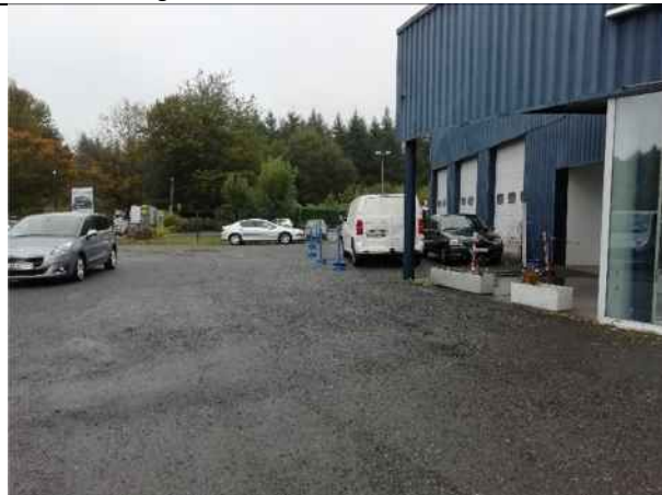
Partie nord – en gravillons noir et enrobé [8]
