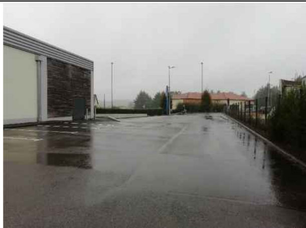
Accès au quai de déchargement en partie ouest [3]
