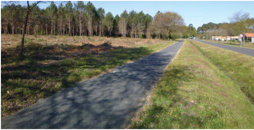
Zone urbanisée et Bas-côté enherbé (dans et hors emprise projet) ©ETEN Environnement 14/04/2021
