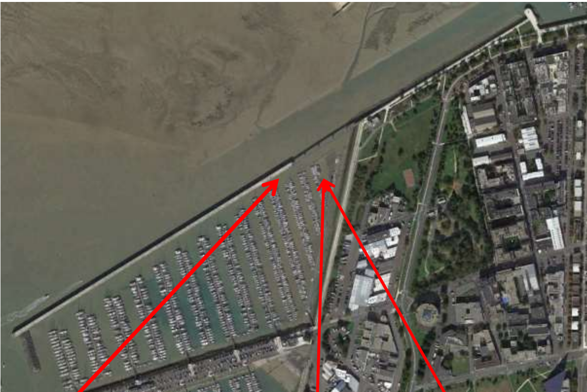
Photos de la zone d'implantation du ponton brise clapot :
