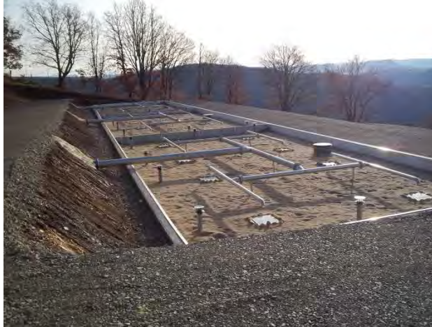
Exemple de réalisation avant implantation des roseaux
