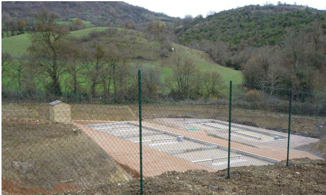
Exemple de réalisation avant implantation des roseaux
